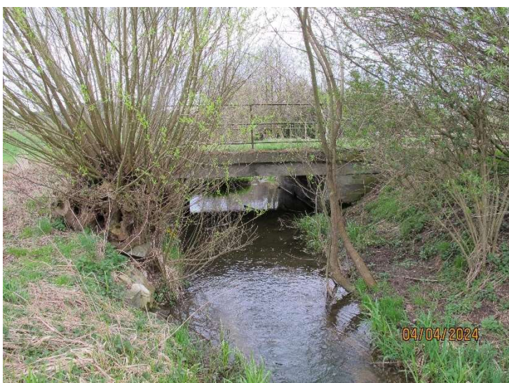
Pohled na návodní stranu mostu zleva, po směru toku potoka.
