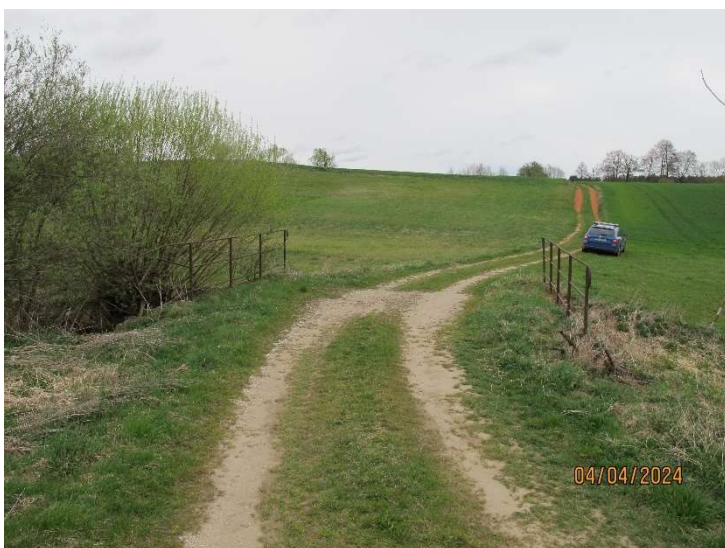
Pohled po směru staničení.
