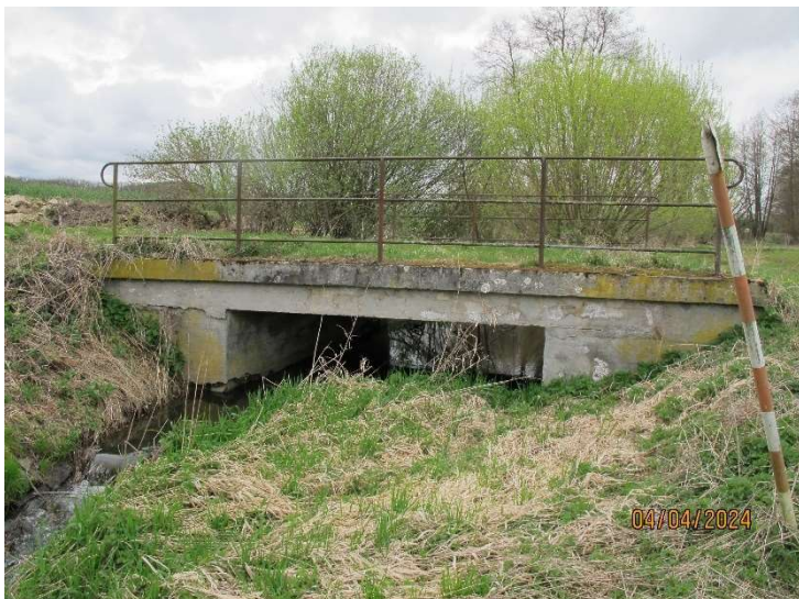
Pohled na povodní stranu mostu zprava, proti směru toku potoka.
