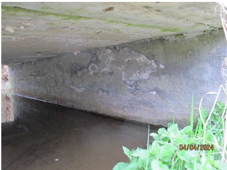
Pohled na opěru O2.
