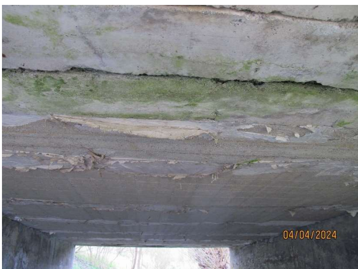
Pohled nosné konstrukce.
