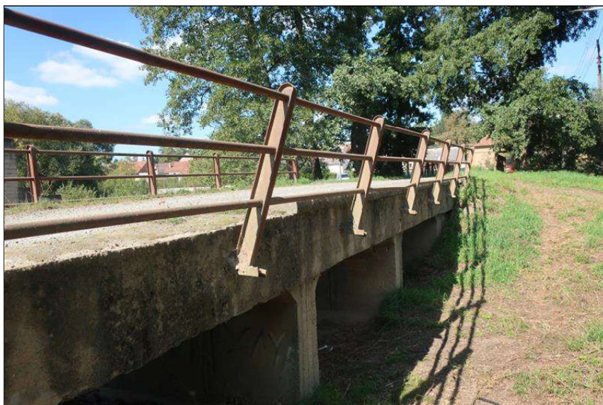
detail levého zábradlí
