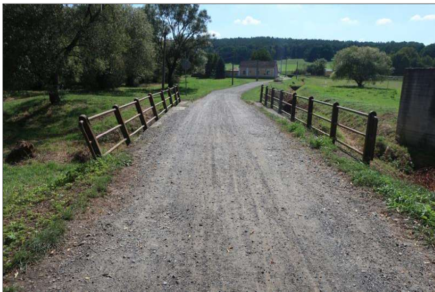
příčné uspořádání na mostě ve směru staničení
