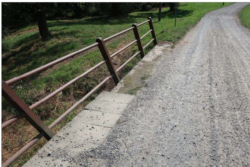
DTTO + částečně rozebrané prefabrikáty levé římsy
