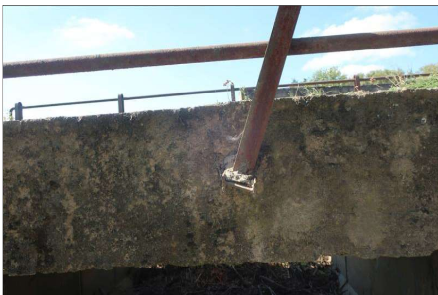
detail kotevní zábradlí
