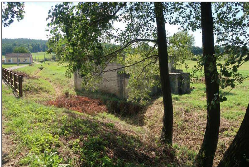
rozestavěná opěra sousedního mostu
