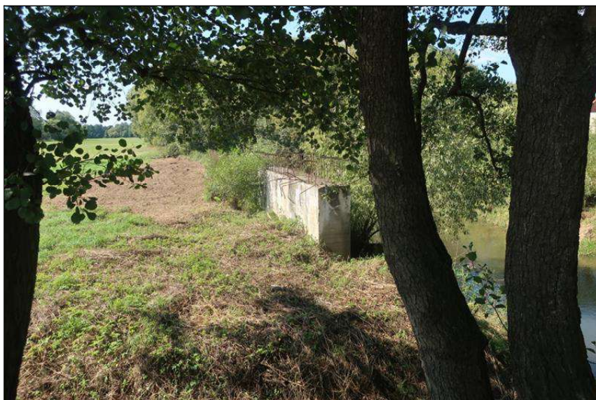
rozestavěný mezilehlý pilíř sousedního mostu
