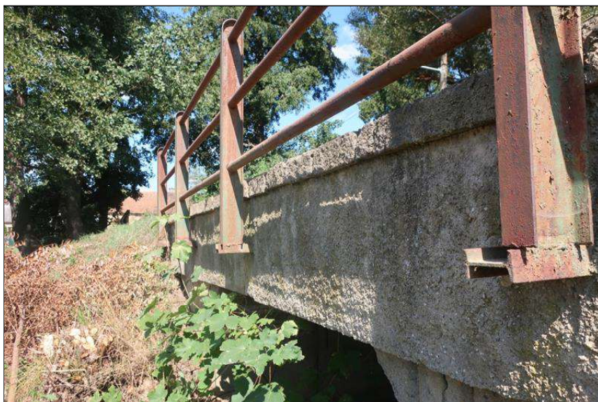
detail kotvení pravého zábradlí
