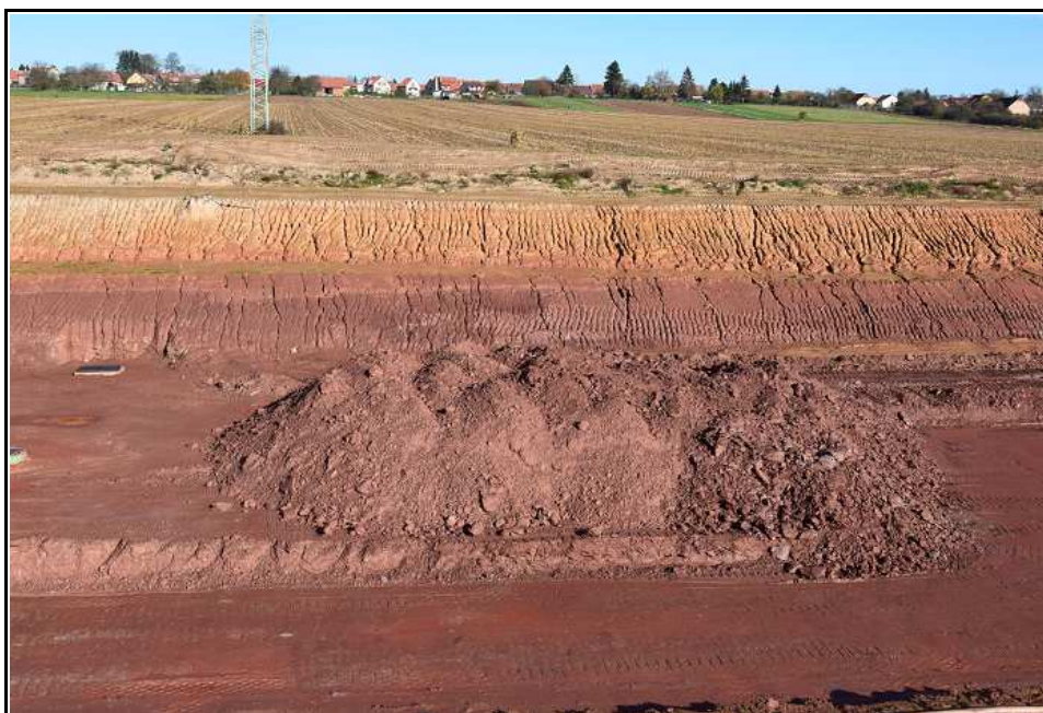
Obr.č. 37: Celkový pohled do zářezu budované D6 přibližně na úrovni vrtu S17 v úseku plochého návrší. Pod nevýraznou vrstvou kvartérního pokryvu odkryto zřejmě týnecké souvrství stáří svrchní karbon tvořené bělošedým pískovcem s rudohnědým jílovcem v podloží.
