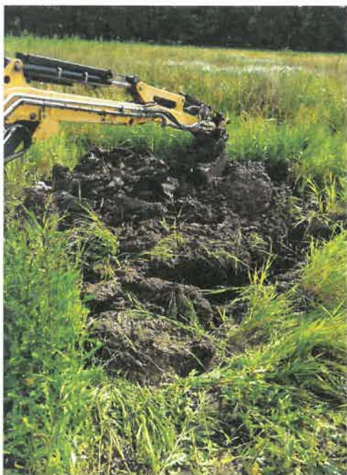
Obr. 1: Hloubení sondy S1
