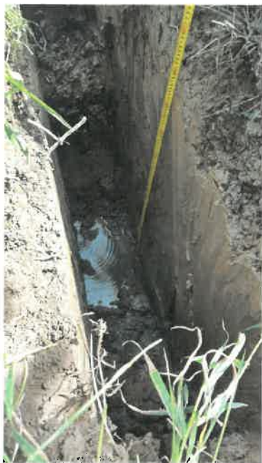
Obr. 2: Hloubení sondy S1
