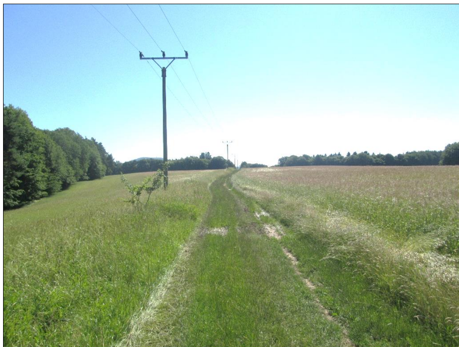
Průběh trasy polní cesty – souběh s nadzemním vedením VN
