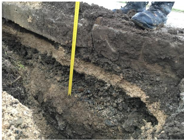
Foto č.2: Stávající konstrukce polní cesty C6
