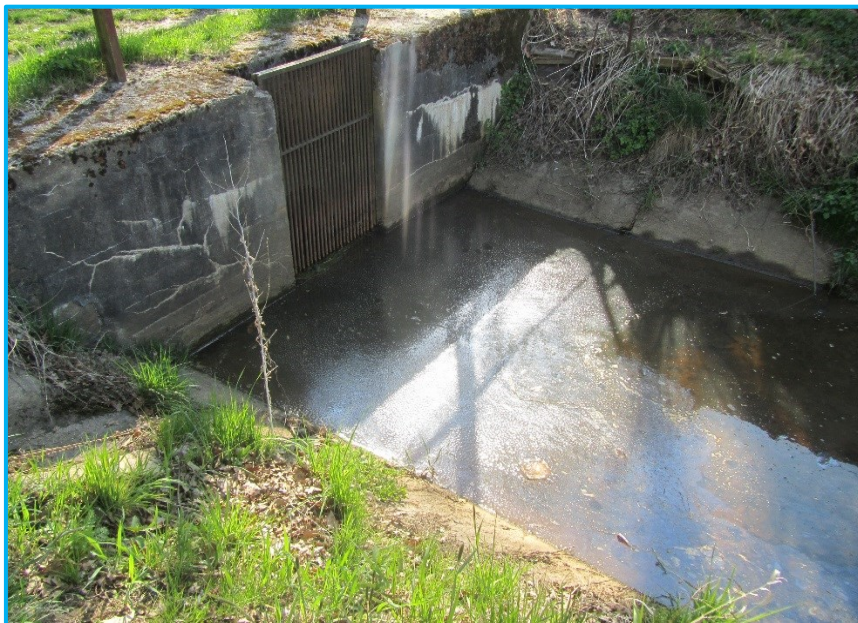
Ukázka – čelo shybky Veselí nad Lužnicí
