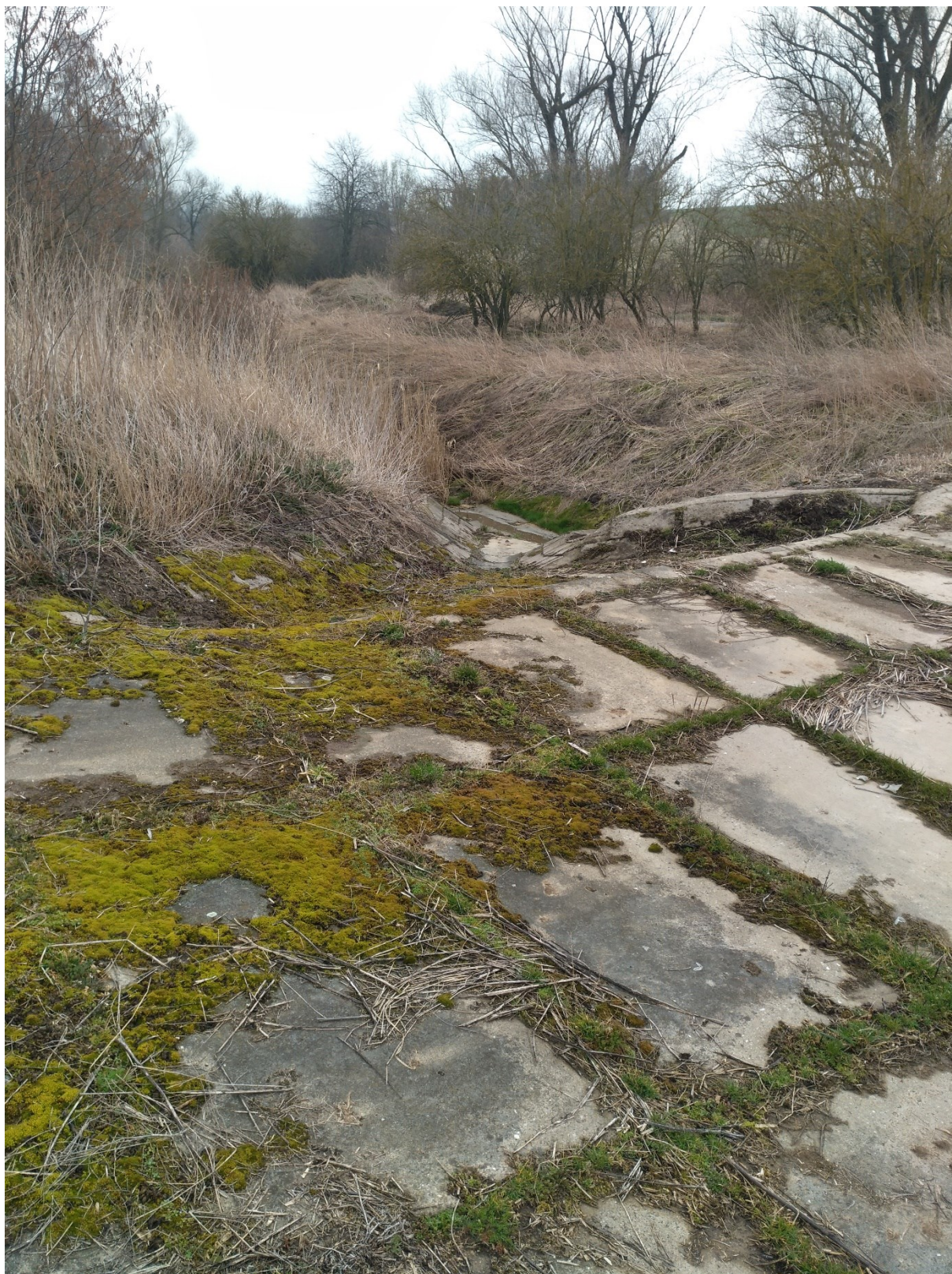
odpad od bezpečnostního přelivu
