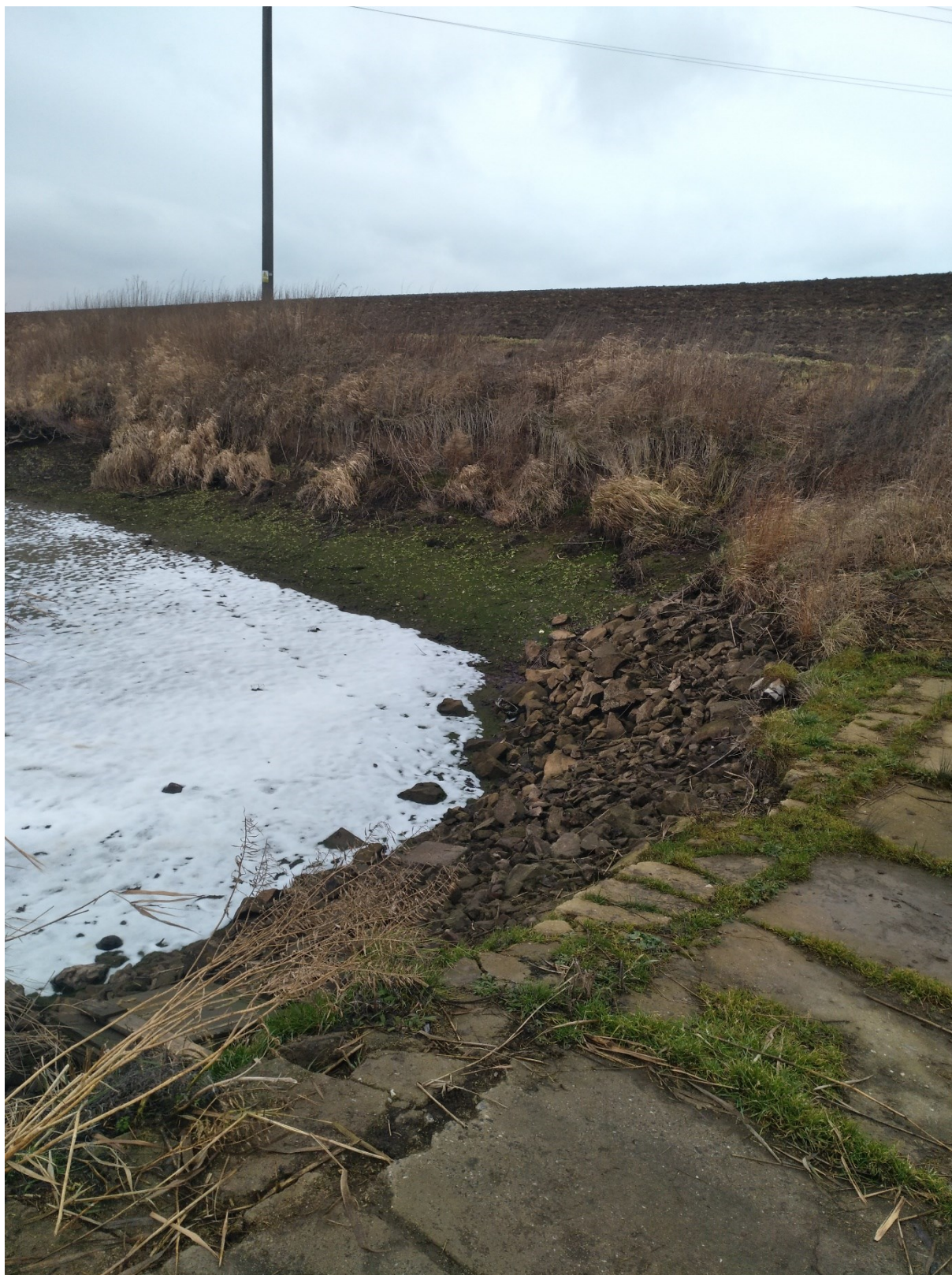
levý břeh se sloupem-pohled z hráze
