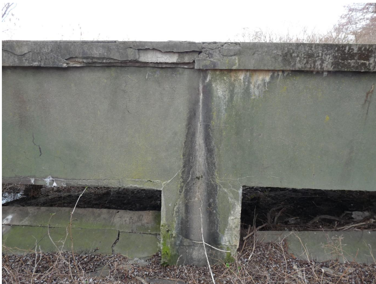
Pohled na pilíř.
