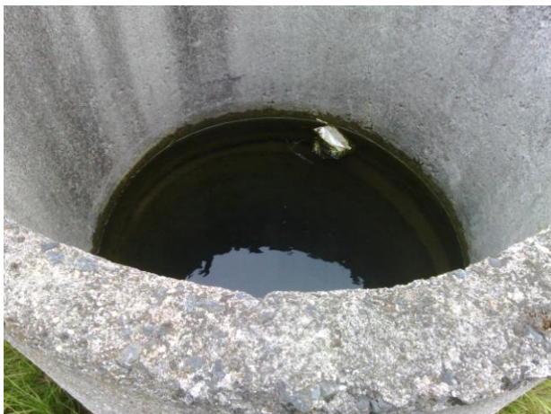
Obr.1: Zatopená armaturní šachta
