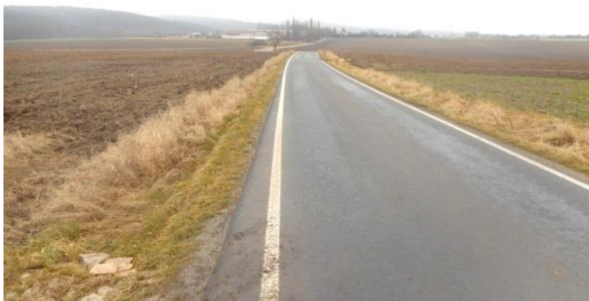
obrázek 2 – Rozhled vlevo ze sjezdu ze začátku polní cesty NCH1 na silnici III/1409 ,bez překážek v rozhledu. Rozhled na vzdálenost 120 m do výšky 1 m nad vozovkou je zajištěn i přes místo vrcholového oblouku.
