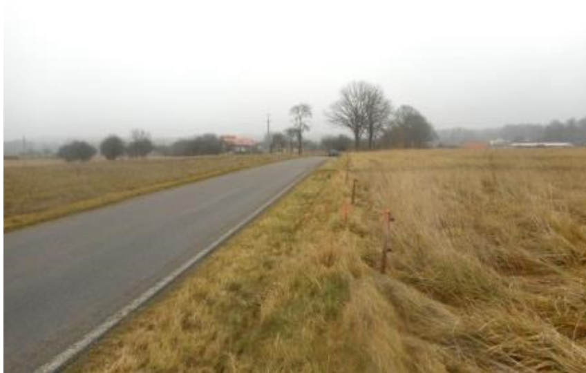
obrázek 4 – Rozhled vpravo ze sjezdu na konci polní cesty NCH1 na silnici III/14010. Rozhled na vzdálenost 100m (ještě před prvním stromem vpravo) je zajištěn bez překážek v rozhledu.
