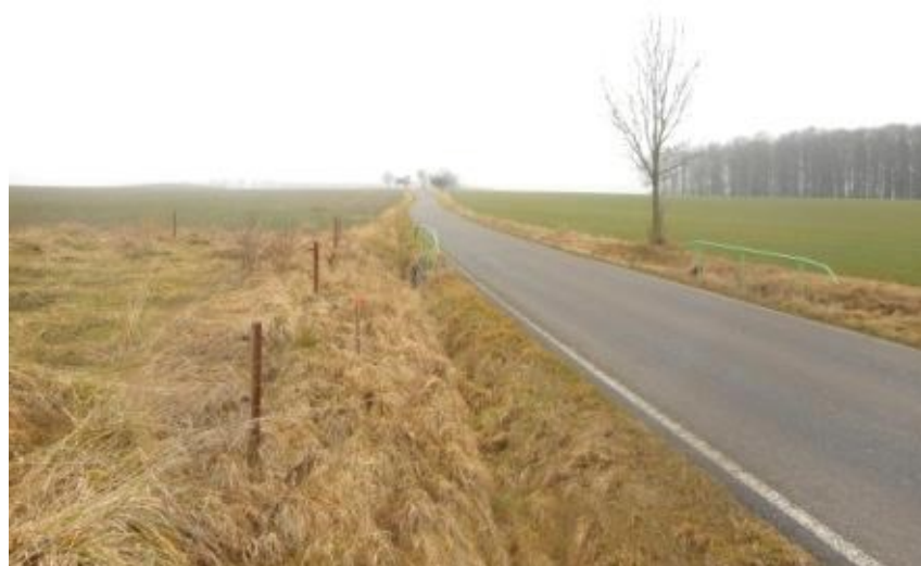
obrázek 5 – Rozhled vlevo ze sjezdu na konci polní cesty NCH1 na silnici III/14010. Bez překážek v rozhledu.
