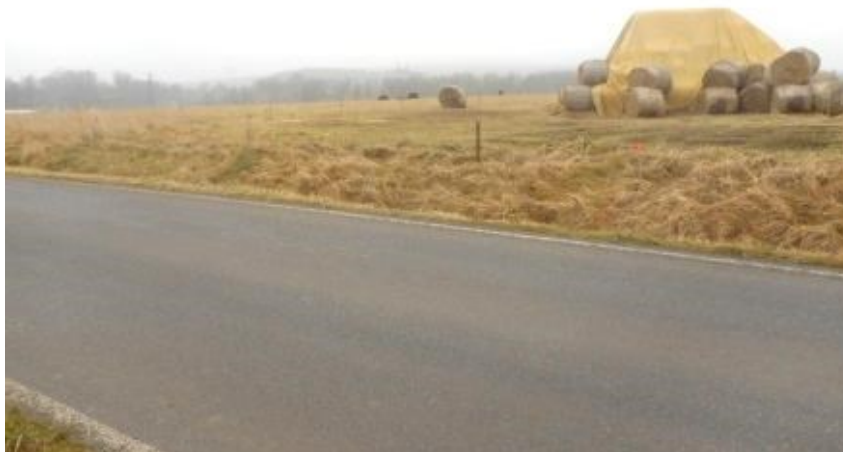
obrázek 6 – Pohled na místo budoucího sjezdu na konci polní cesty NCH1.
