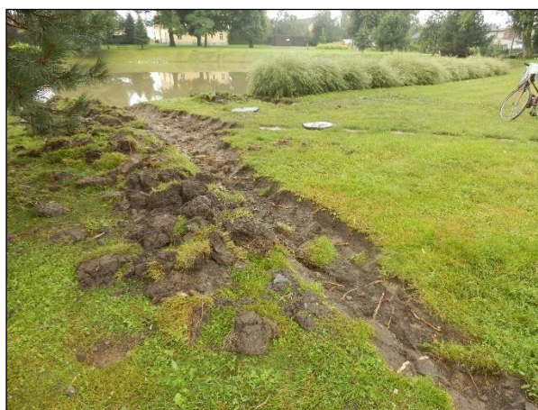
Foto 25: Detail uměle vytvořeného průpichu mezi korytem HOZ a rybníkem.
