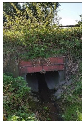
Foto 27: Detail propustku DN1000.
