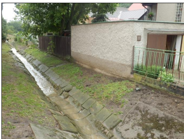
Foto 20: Pohled od mostu na koryto HOZ ve spodní části zástavby. Na nemovitostech viditelná čára zamokření označující výšku hladiny při povodni.
