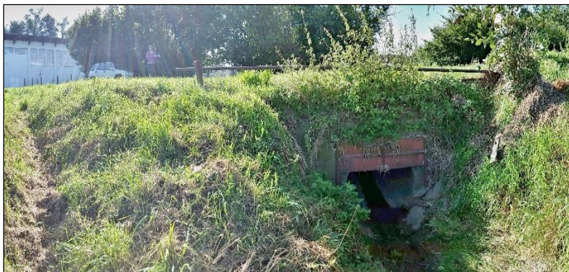
Foto 26: Přímý pohled na závěrový profil, propustek DN1000 vedoucí pod polní cestou.
