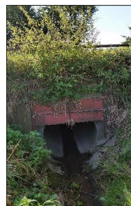
Foto 4: Detail propustku DN1000
