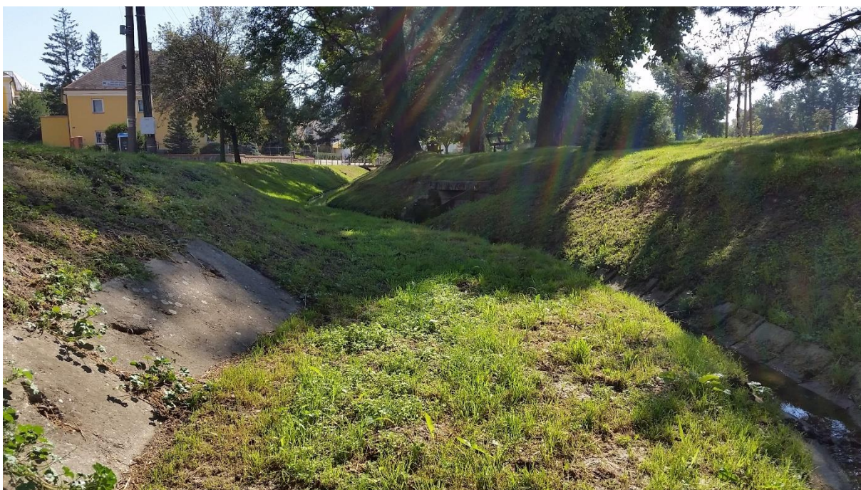
Foto 9: Pohled po proudu, foceno za mostem, vpravo se nachází rybník, vlevo místní komunikace procházející obcí. Koryto toku má v tomto profilu lichoběžníkový profil.
