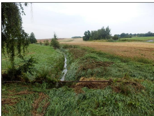
Foto 14: Pohled na závěrový profil. Koryto HOZ nestačilo převést povodňové průtoky. Došlo k rozlivu vod na okolní pozemky.
