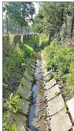
Foto 6: Detail opevnění svodného příkopu – betonové žlabovky
