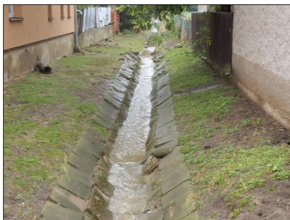
Foto 21: Detail na koryto HOZ, vpravo na zdi viditelná čára zamokření označující výšku hladiny při povodni.
