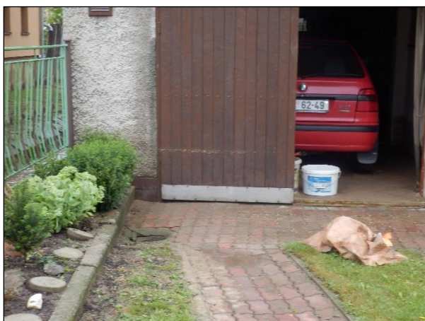
Foto 22: Detail na vrata od garáže. Světlá barva na vratech dokládá výšku hladiny při povodni.
