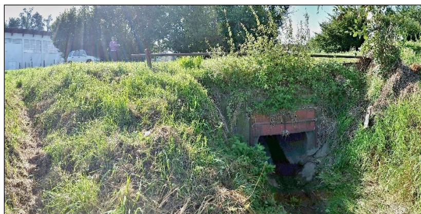
Foto 3: Přímý pohled na závěrový profil, propustek DN1000 vedoucí pod polní cestou. Místo má snížený průtočný profil s funkcí krátkodobé snížení kulminačních průtoků
