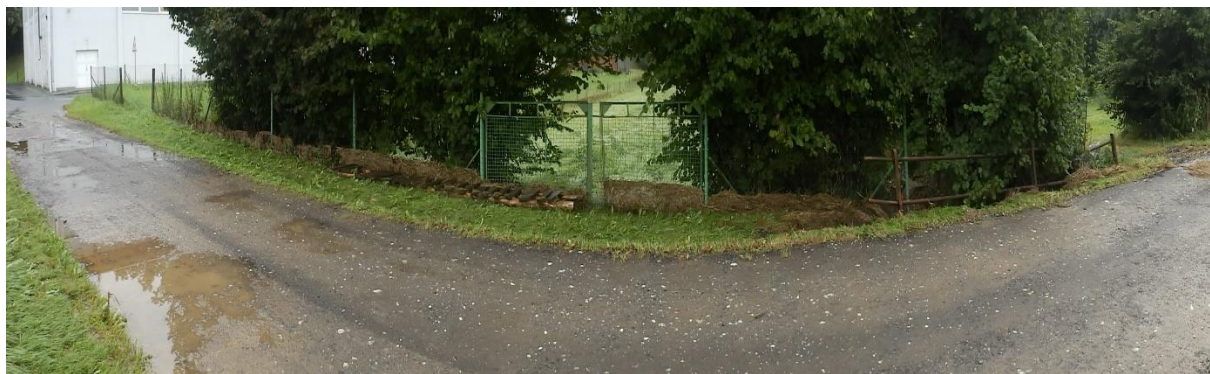
Foto 12: Vpravo zábradlí nad propustek DN1000. Voda přetékala přes povrch polní cesty směrem na pozemky níže. Výšku hladiny při povodni dokládá tráva zachycena na oplocení.
