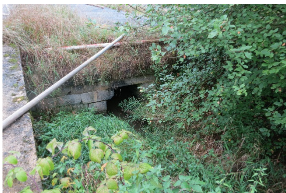
Obrázek 5: Vtokové čelo propustku (KP1)
