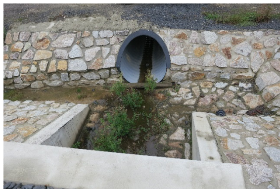
Obrázek 14: Vtok do propustku DN800
