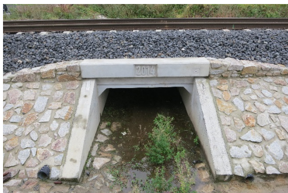
Obrázek 15: Výtokové čelo ŽB propustku
