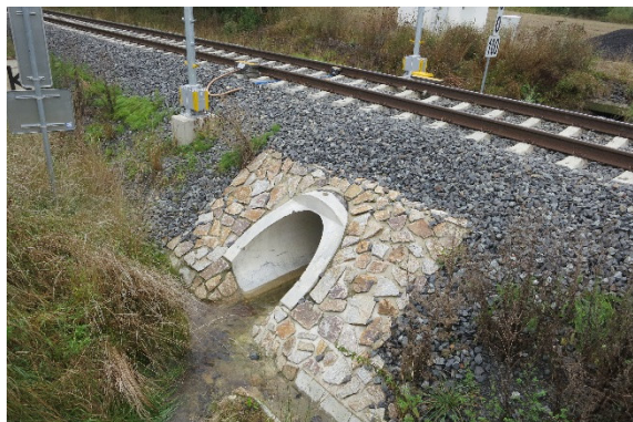
Obrázek 6: Výtokové čelo propustku (KP2)
