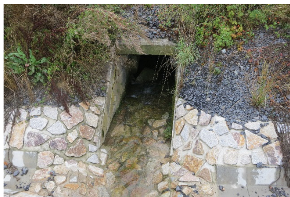
Obrázek 4: Vyústění propustku (KP1)
