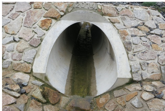
Obrázek 7: Vtokové čelo propustku (KP2)
