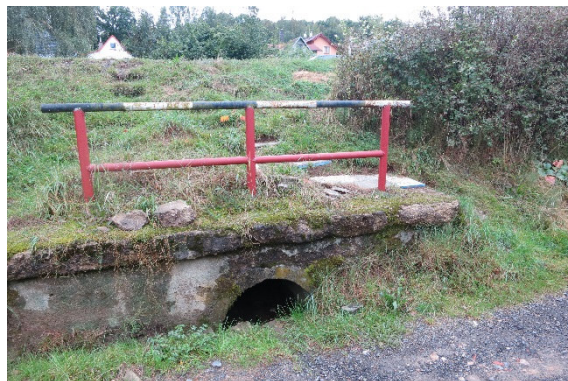
Obrázek 16: Výtokové čelo propustku pod silnicí č. II/606
