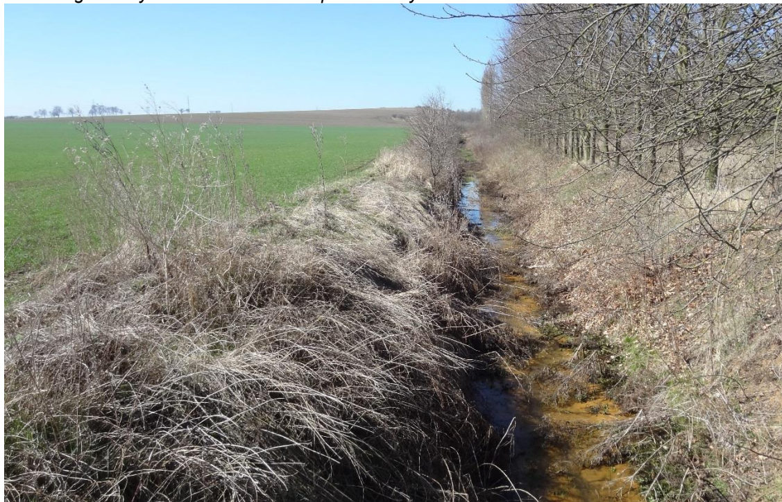
Obr.: Regulovaný úsek Počeradského potoka u Výškova
