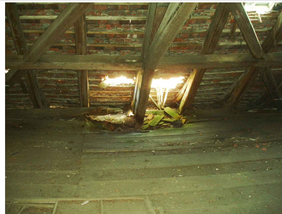
Půda uhnilé krokve v plné vazbě, zakořeněný stromek
