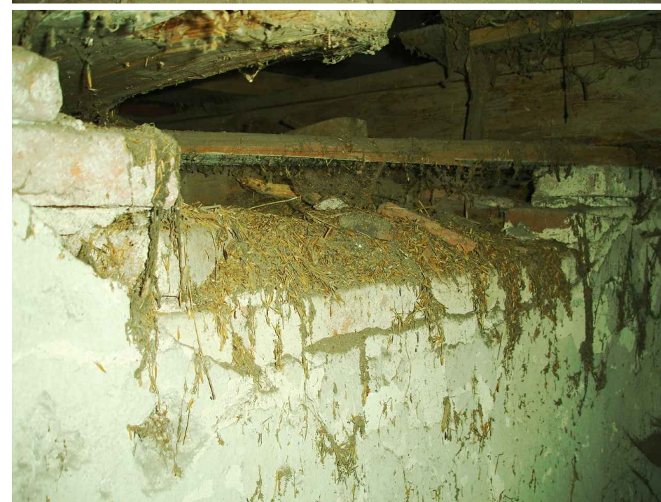
Půda poškození zdiva a trámů u schodiště
