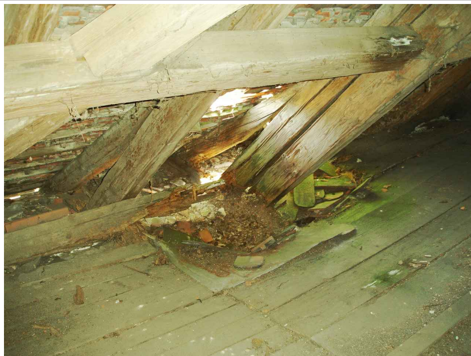
Půda uhnilé krokve v plné vazbě
