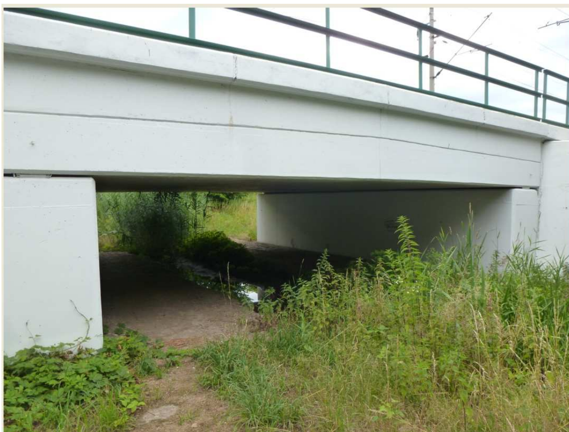
Most přes Pekelský potok na trati Kolín - Praha
