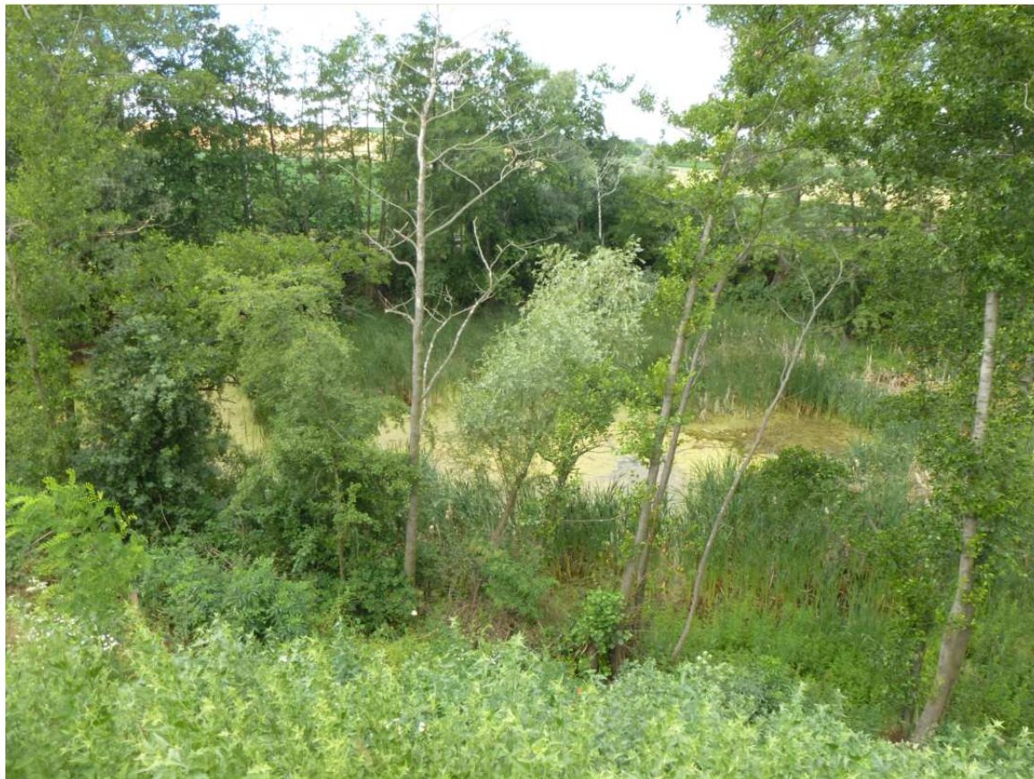
Funkční zachytňá a zasakovací nádrž nad nadjezdem u trati na silnici I/38.
