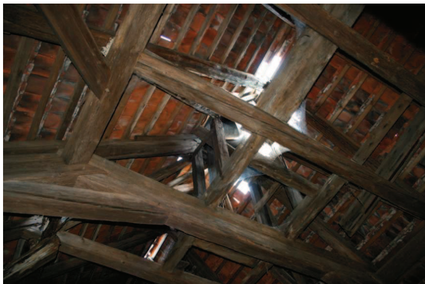
Obr. č. 10: Kolem sanktusníku (zvoničky) dlouhodobě zatéká. Celá spodní pata věžičky je nevratně narušena a hrozí celkový propad.
