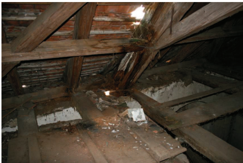
Obr. č. 1: Hluboce degradovaná plná vazba, pozednice a zhlaví vazných trámů. Jíž došlo k prolomení vazného trámu a hrozí celkový propad.
