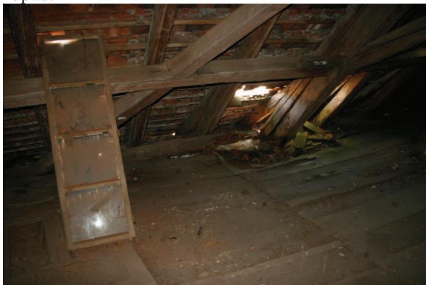
Obr. č. 2: Hluboce degradovaná sousední plná vazba krovu - hrozí celkový propad.
