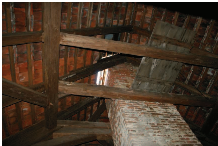
Obr. č. 8: Kolem zděného komínu dlouhodobě zatéká - rozvoj hniloby.
