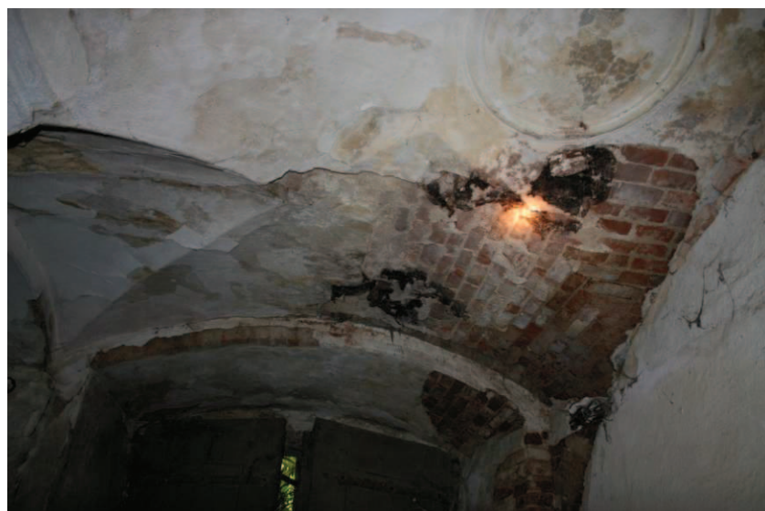
Obr. č. 18: Plodnice dřevomorky prorůstají i zděné konstrukce a klenby!
