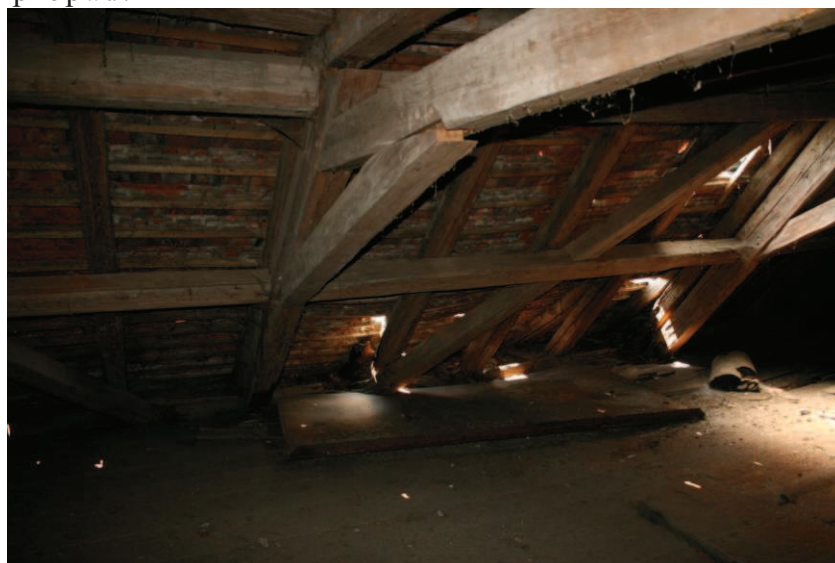
Obr. č. 3: Propad krovu v plných vazbách. Jedná se havarijný stav. Ve spojích je patrné vyjetí čepů a tvarové deformace krovu.
