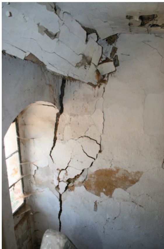
Obr. č. 18: Patrné celkové narušení statiky objektu vlivem podélného posuvu krovu - Jedná se o havarijní stav a hrozí celkový propad.
