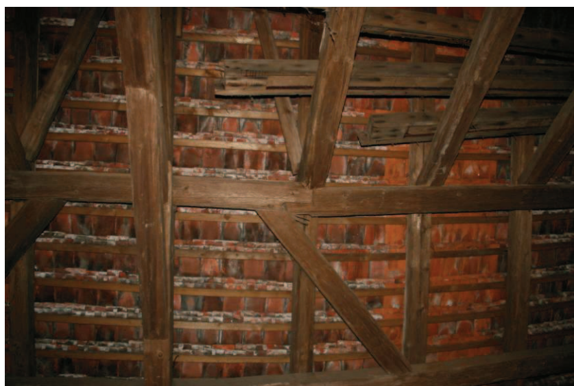
Obr. č. 9: Vlivem poklesu spodní paty krovu dochází k tvarovým deformacím a prolomení vaznic.
