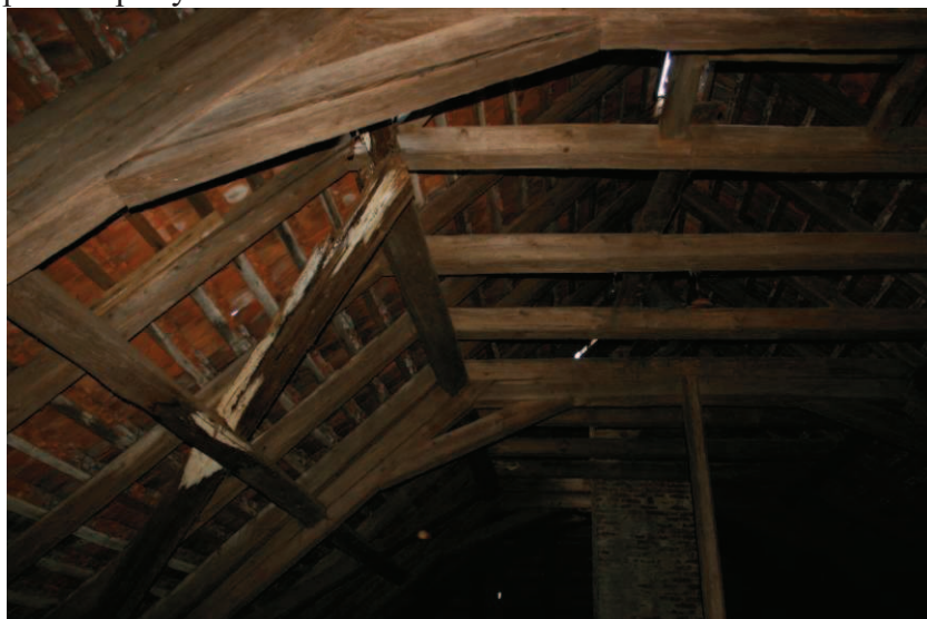
Obr. č. 5: Na mnoha místech do krovu dlouhodobě zatéká - krov je tak nevratně narušen.
