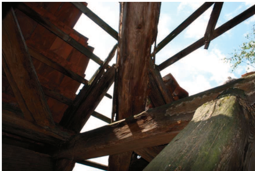
Obr. č. 7: propad střešního pláště u komínového průduchu.
