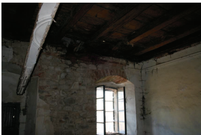
Obr. č. 11: Propad stropních konstrukcí způsobilo nekontrolovatelné šíření dřevomorky domácí ve spodní patě krovu.
