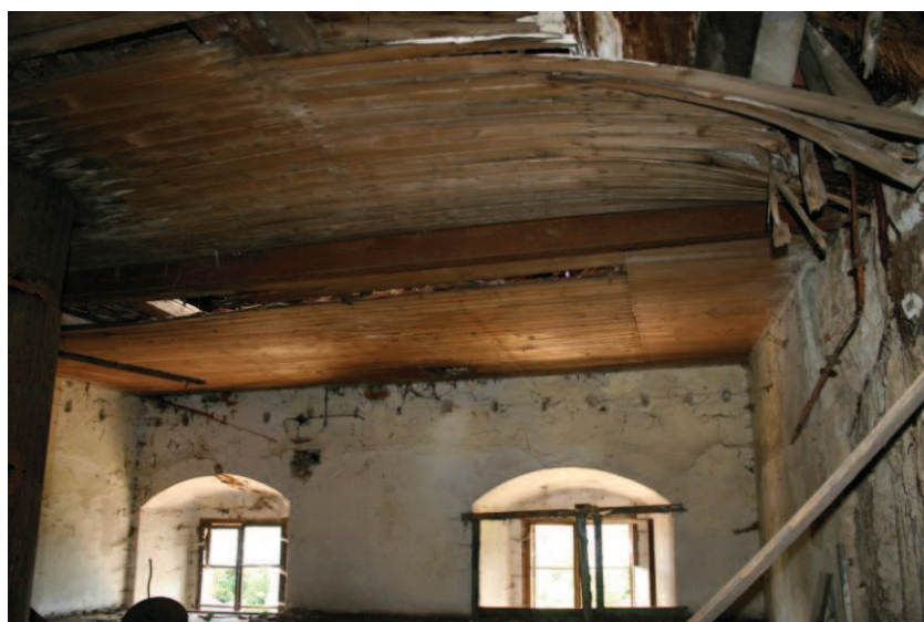
Obr. č. 14: Propad stropní konstrukce ve valbě okolo technologie lihovaru.
