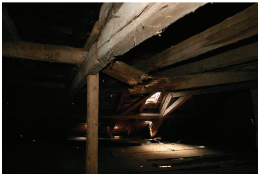
Obr. č. 4: Krov pod věžičkou hluboce degradovaný v obou úrovních až do spodní paty krovu.
