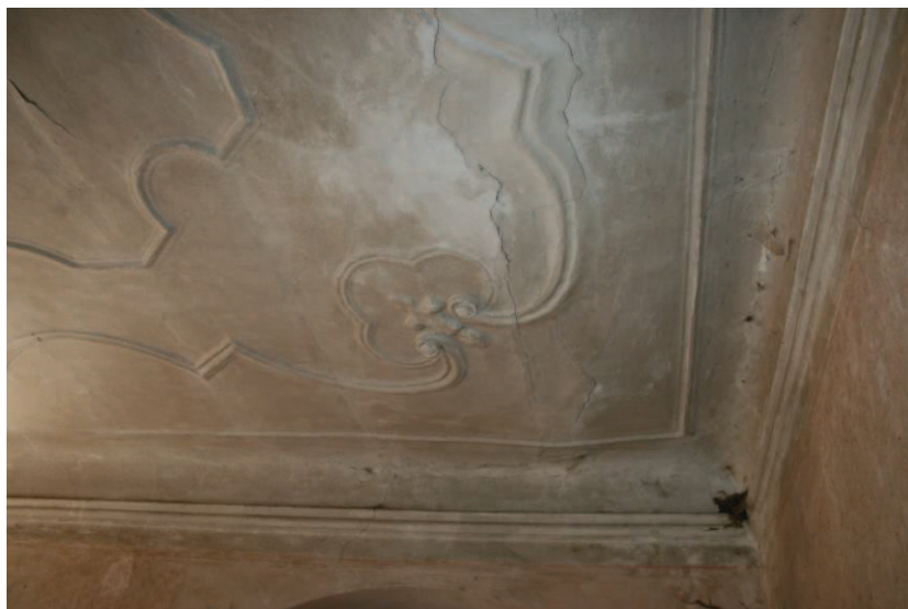
Obr. č. 13: Patrný starý propad stropních konstrukcí i valbě směrem do ulice.
