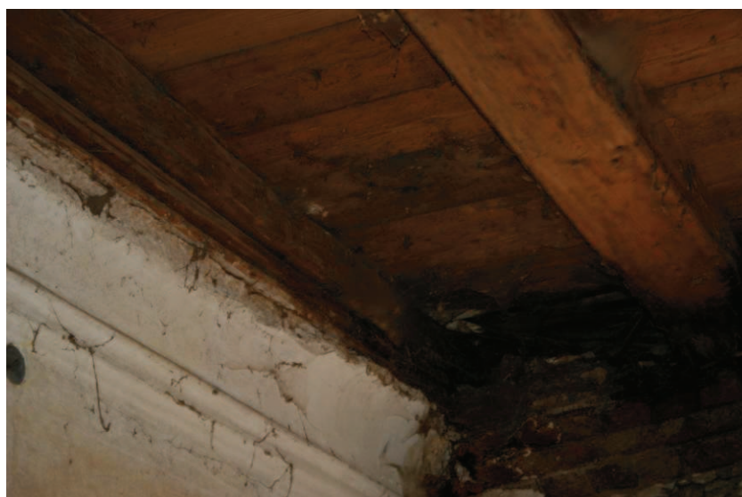
Obr. č. 12: Hluboce zahnilá stropní konstrukce - rozvoj dřevomorky domácí.
