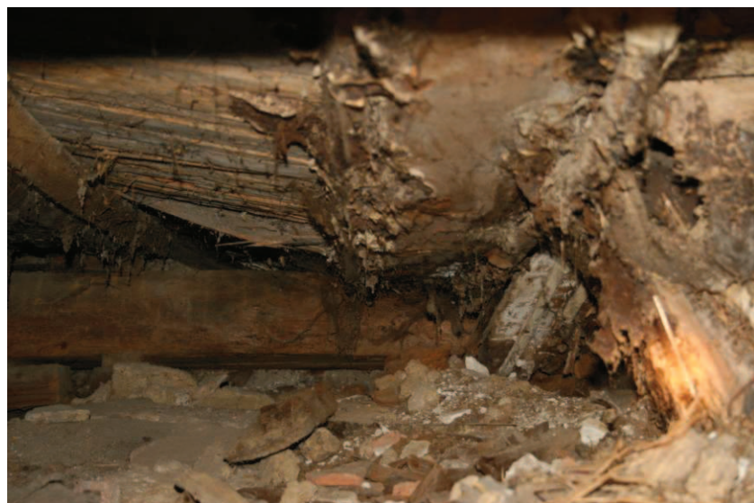
Obr. č. 17: Pohled do stropní konstrukce. Velké narušení a rozšíření dřevomorky domácí!
