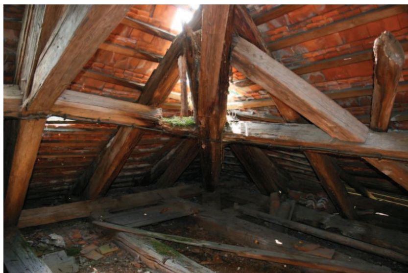
Obr. č. 6: Hluboké narušení valby v místě přilehlého lihovaru - propad.
