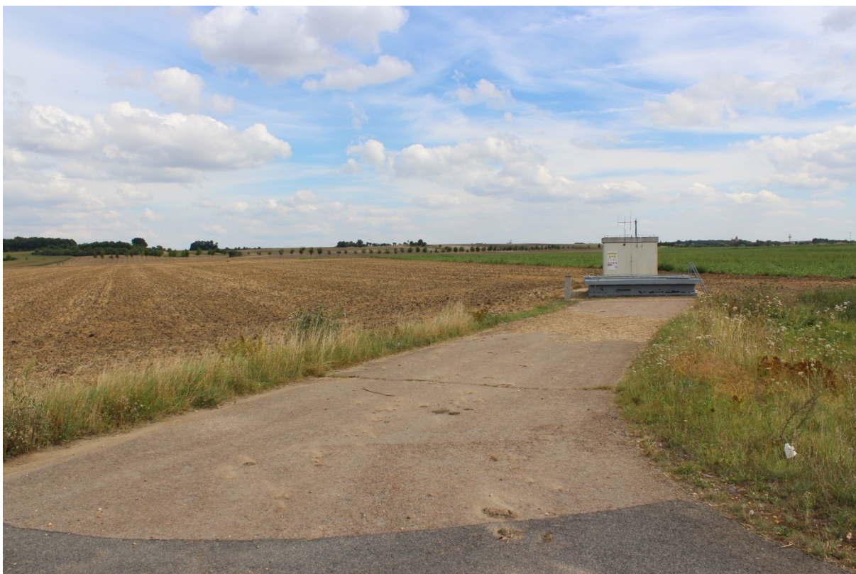
Obr. 50. Stávající sjezd využitelný pro polní cestu PC 19
