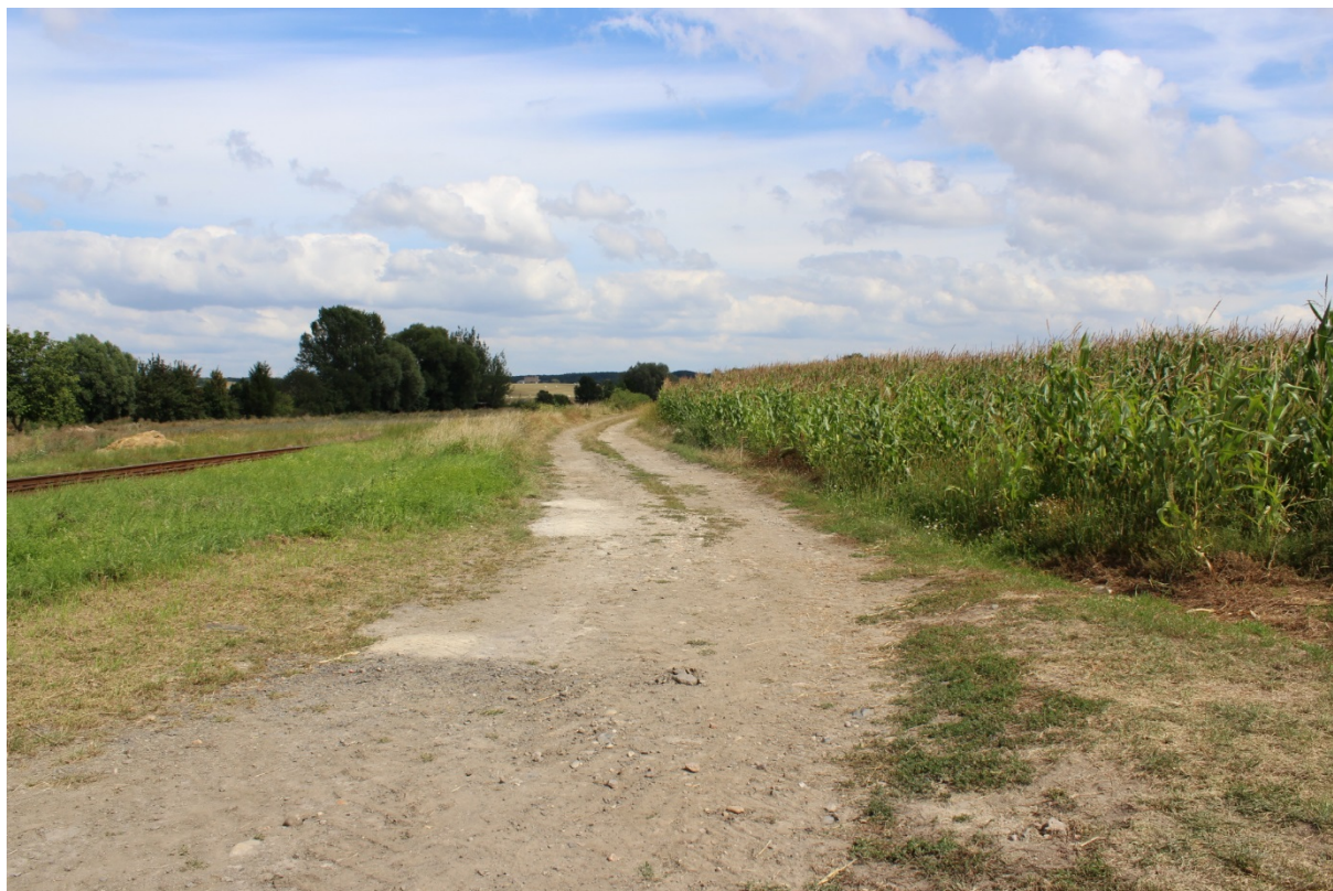
Obr. 36. Polní cesta PC 9 – současný stav
