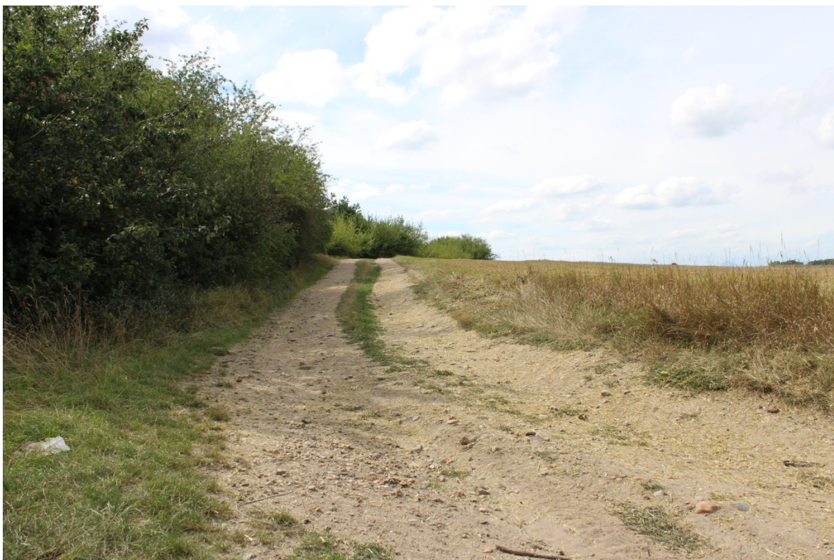
Obr. 45. Polní cesta PC 15 – současný stav
