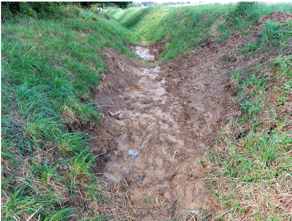
Místo propadu po provizorním zahrnutí
