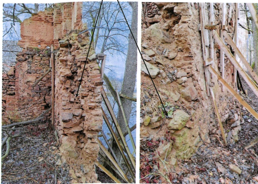
Tvrz Lhotice – torzo bašty - aktuální zhodnocení stávajícího stavu stavby, nástin nezbytných záchranných prací. Arch. M. Hanzl - 3.2024
