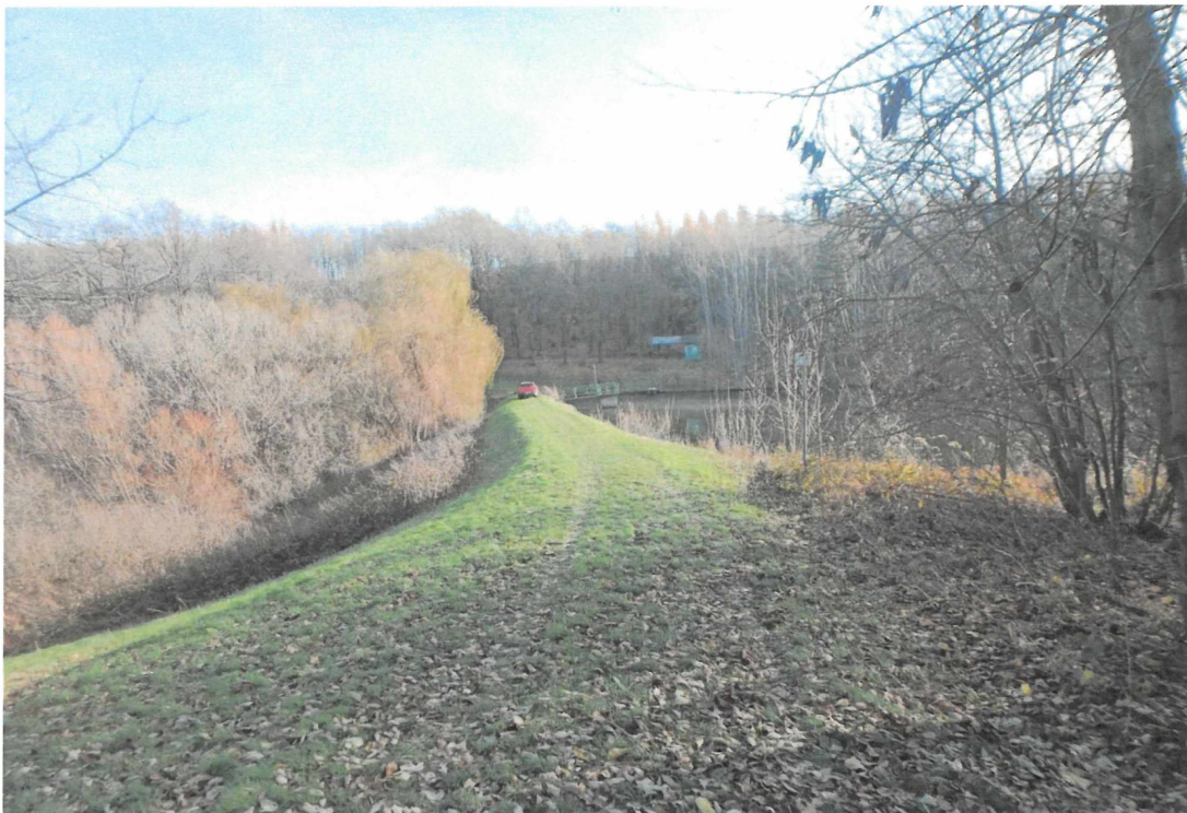
Obr. 1 – Pohled na korunu hráze
