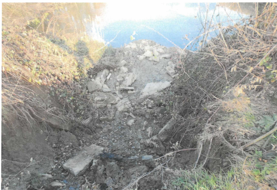
Obr. 5 – Výmol - odplavený materiál prakticky do dvou třetin profilu hráze
