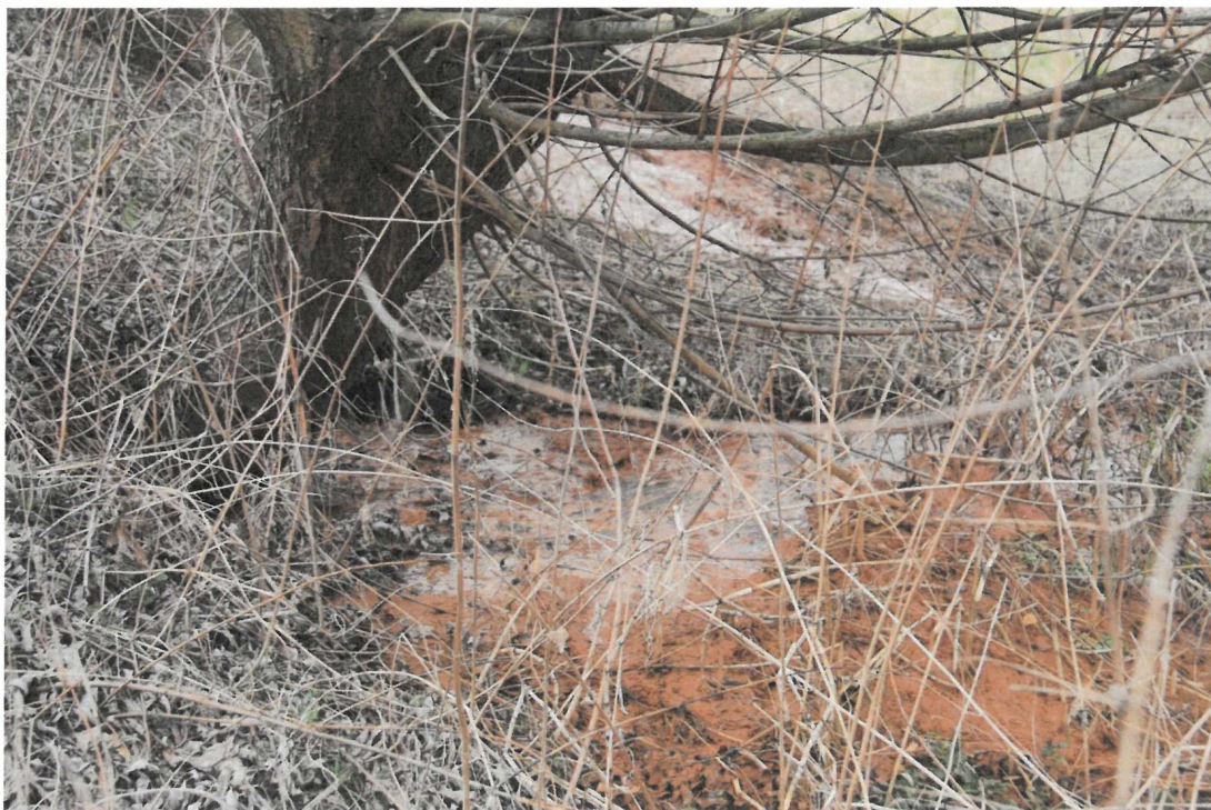
Obr. 6 – Výron vody při vyšší hladině vody v nádrži
