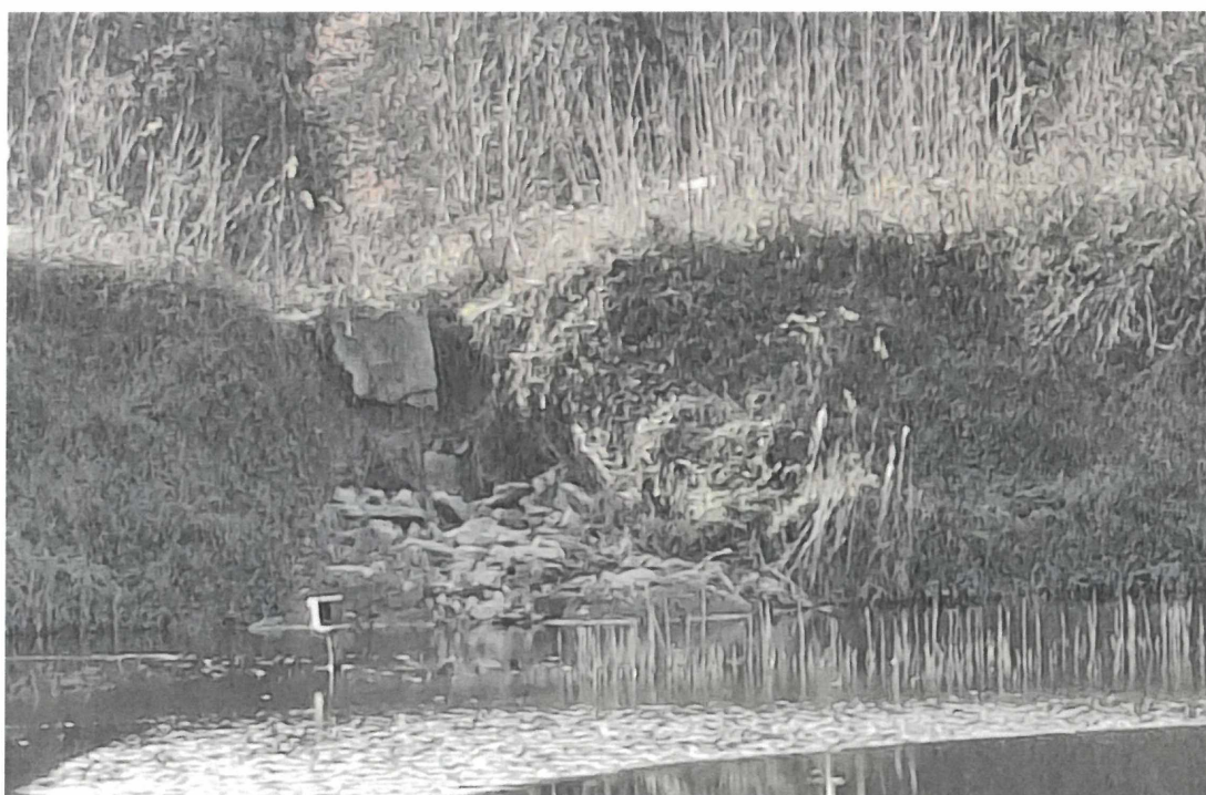
Obr. 5 – Výmol - odplavený materiál prakticky do dvou třetin profilu hráze
