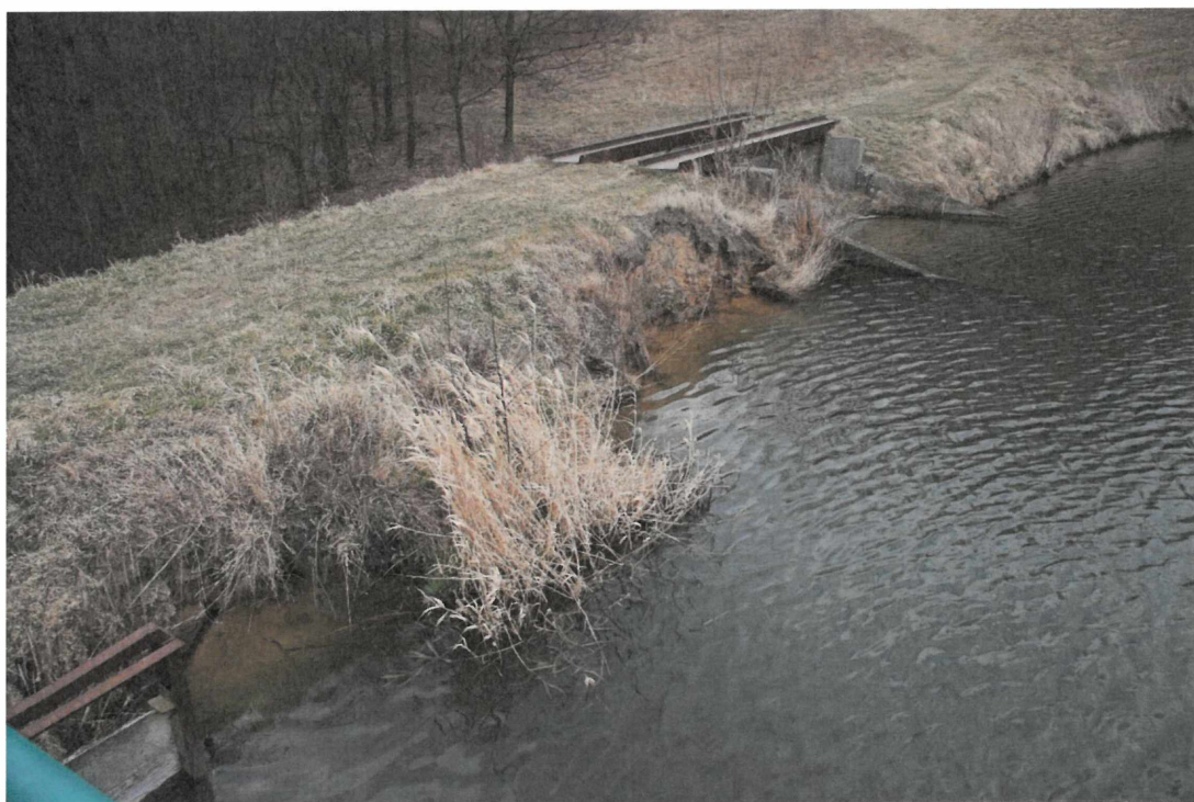
Obr. 3 – Poškození opevnění v oblasti za požerákem
