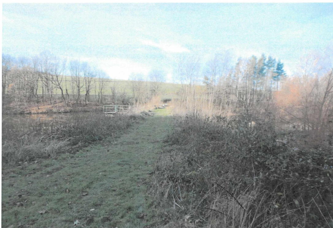
Obr. 1 – Pohled na korunu hráze
