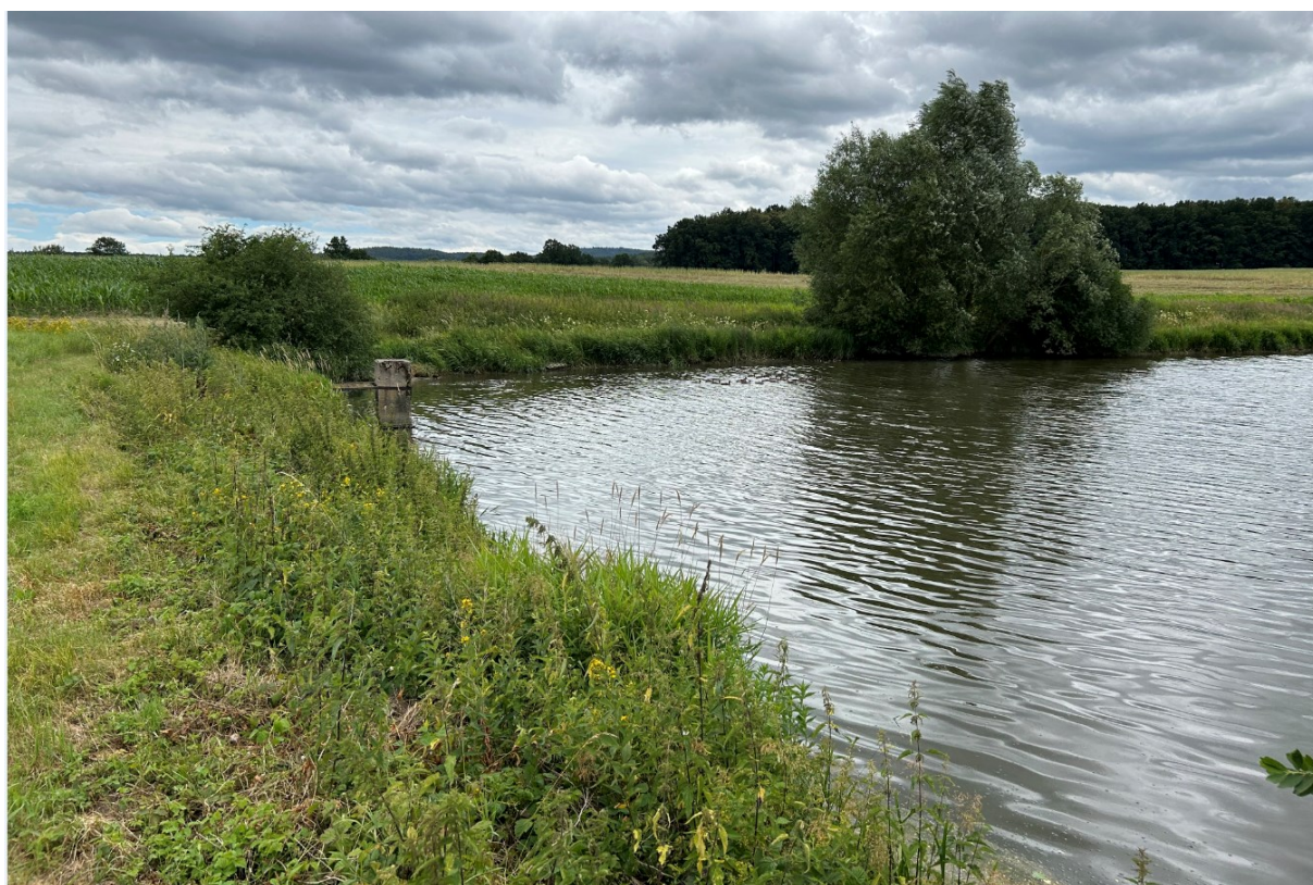
pohled na hráz a požerák (za ním křoviny v místě bezpečnostního přelivu)
