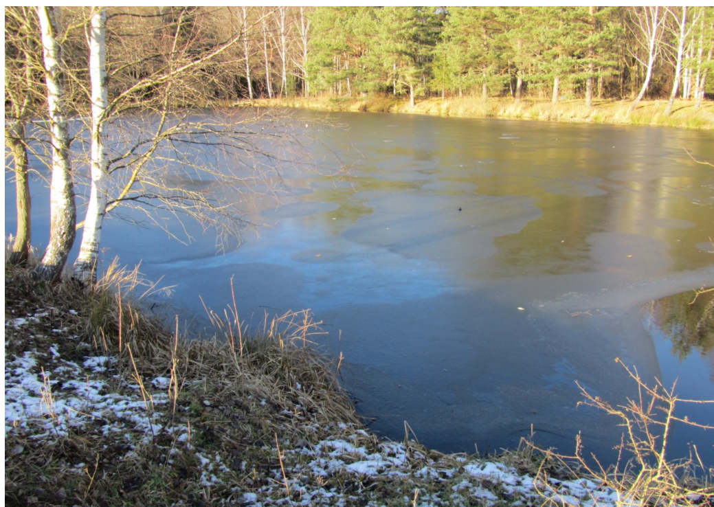
pohled na hráz
