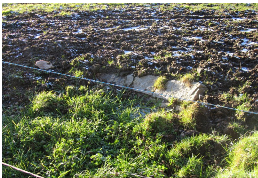
sběrný příkop P1 – místo zaústění trubní části do otevřené části – detail
