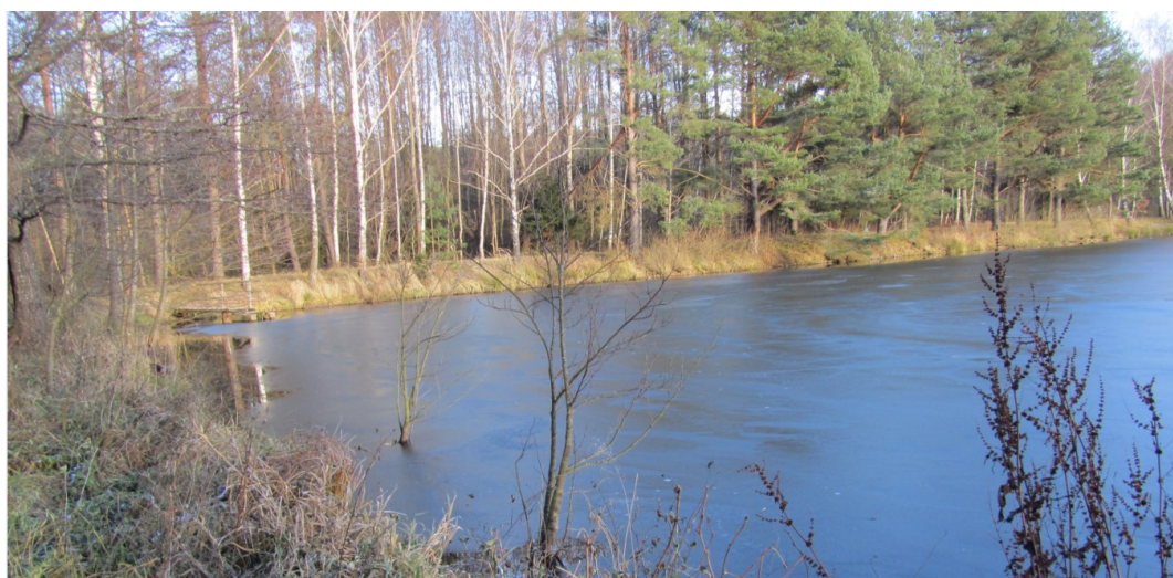
pohled na hráz
