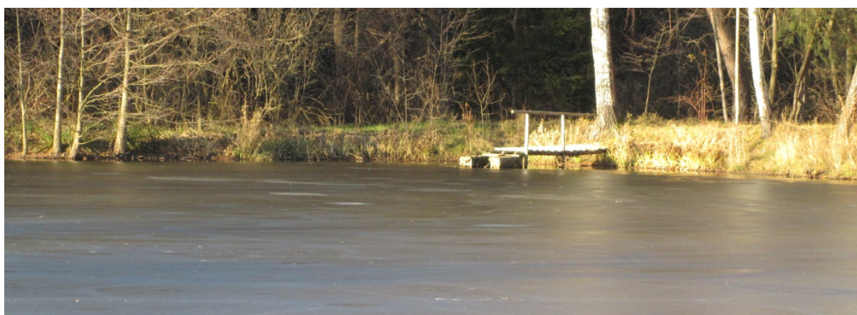
pohled na hráz a požerák
