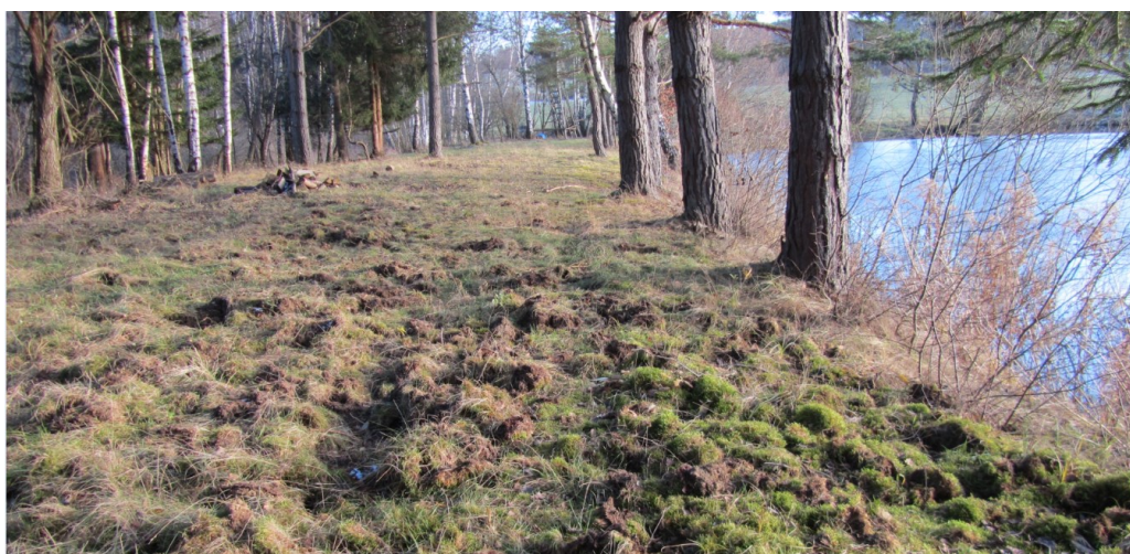
pohled na hráz
