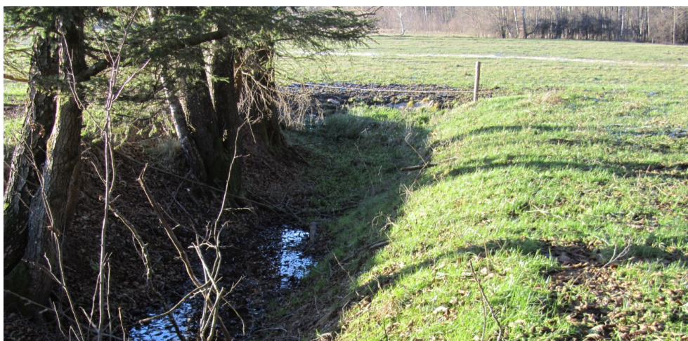
sběrný příkop P1 – místo zaústění trubní části do otevřené části
