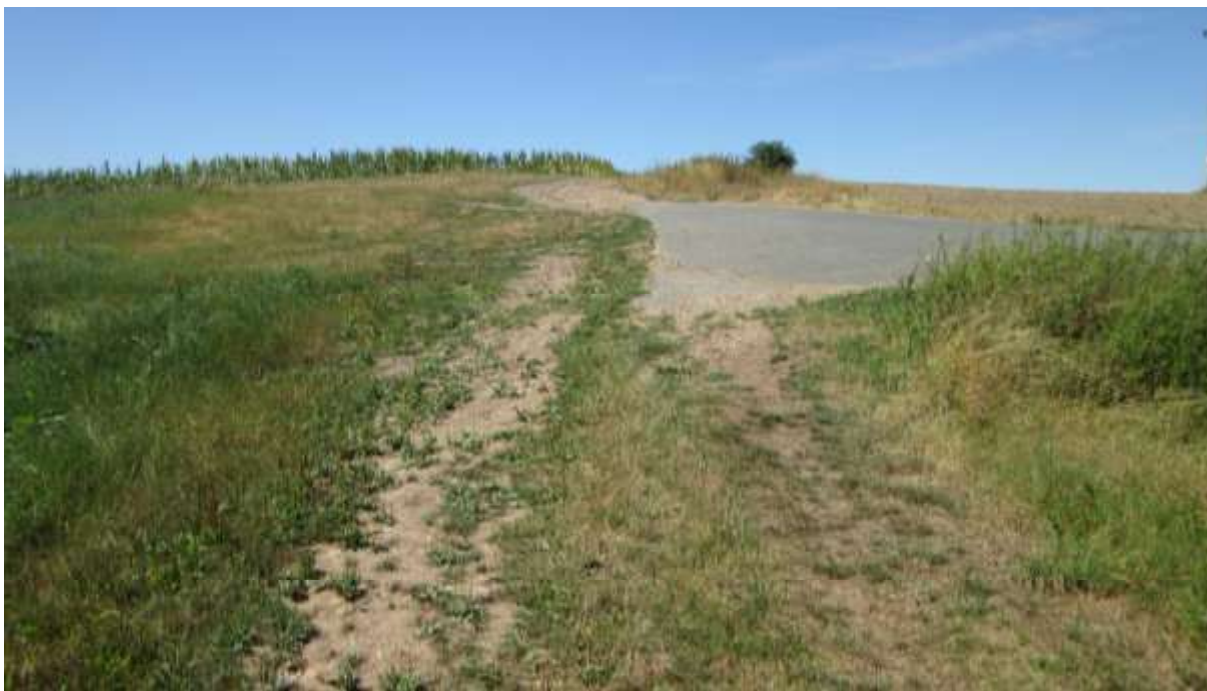
Obr. 4: Pohled na aktuální stav polní cesty C10 v místě křížení s další polní cestou. Úsek nad asfaltem zpevněnou částí je nejvíce ohrožen vodní erozí.
