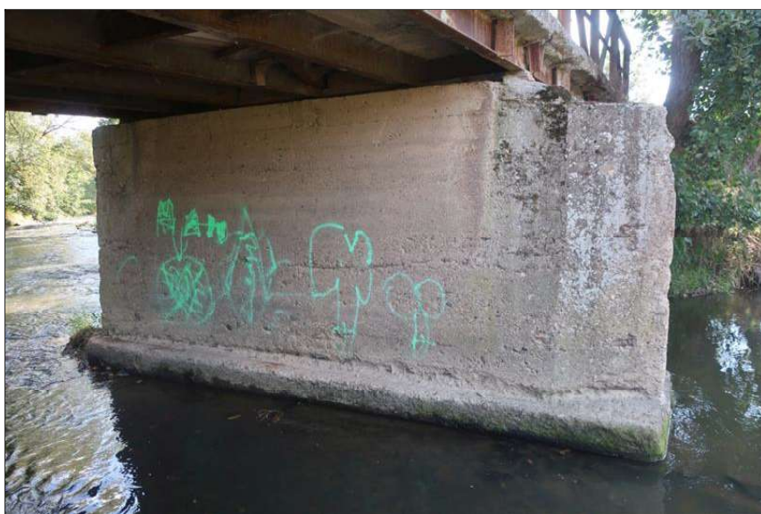
pohled na píliř 2 od opěry 1
