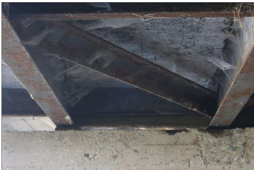
podhled nosné konstrukce ve 2. poli
