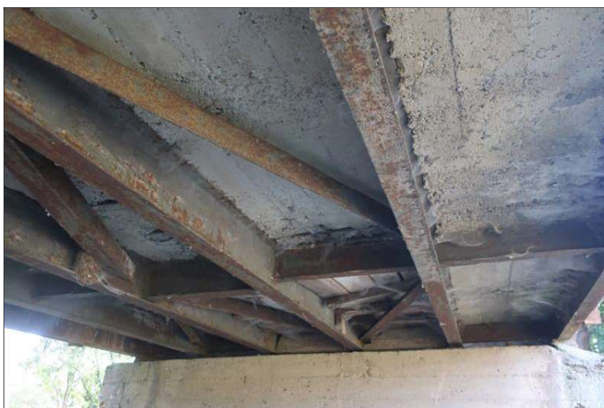
podhled desky mostovky v 1. poli od O1
