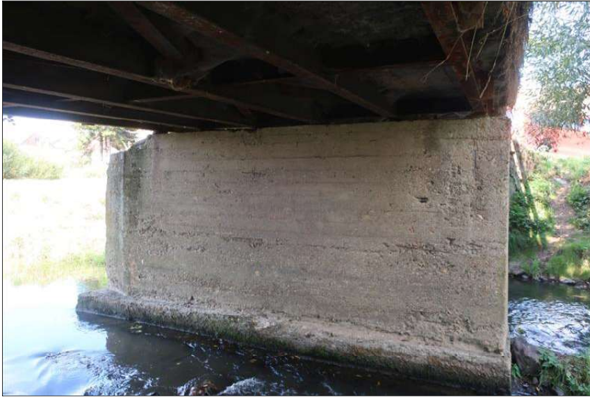
pohled na pilíř P2 od opěry O3
