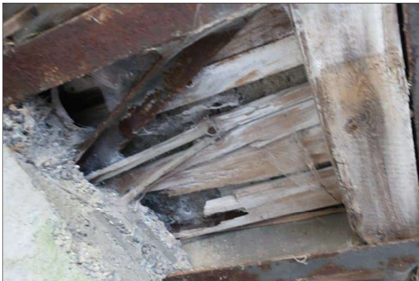
spodní líc mostovky je částečně zabedněn z doby stavby
