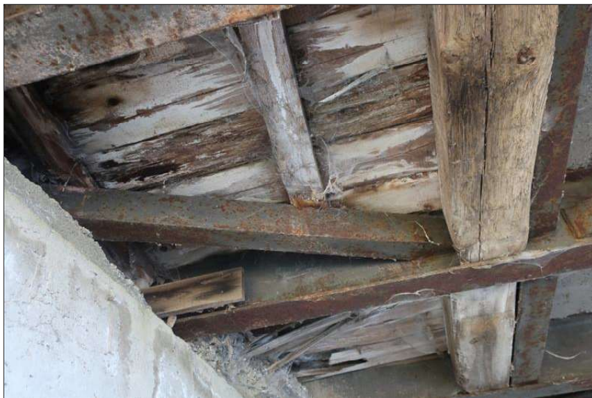
podhled mostovky je částečně zabetonován z doby stavby mostu
