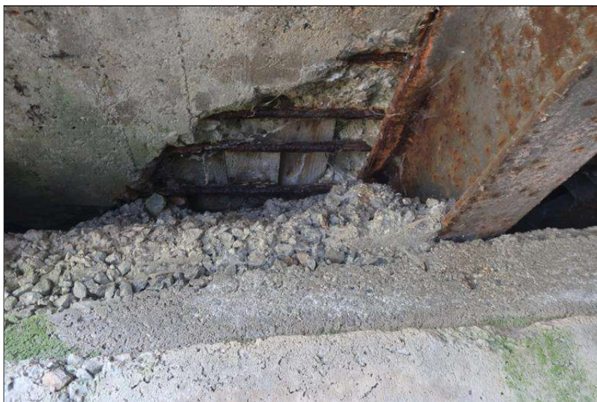
část desky mostovky nad O1 bez betonu, který nahradila prkna
