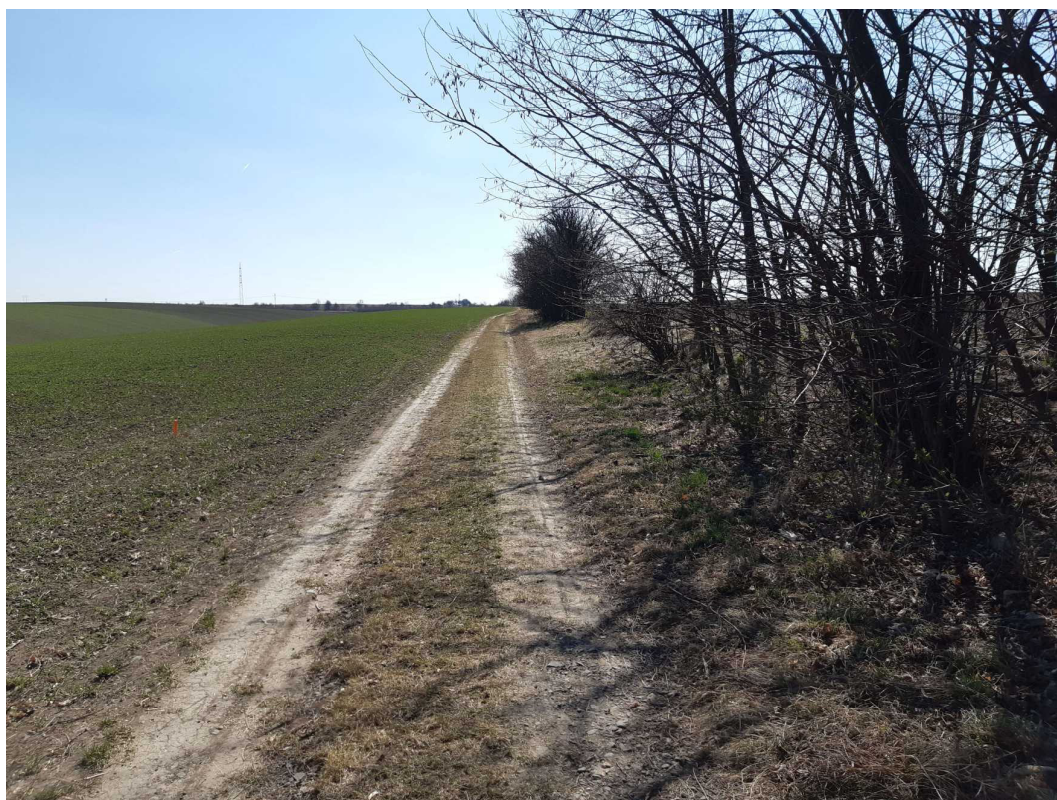
Obr. 5 – pohled na polní cestu C10 podél LBK6 – zpevnění mechanicky zpevněným kamenivem, levostranný příčný drén, svedení drénu do vsakovacích jam v LBK6
