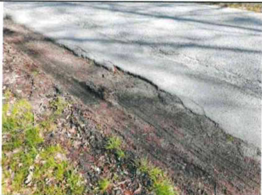
Foto č. 3 – poškození vzdušné hrany koruny hráze
