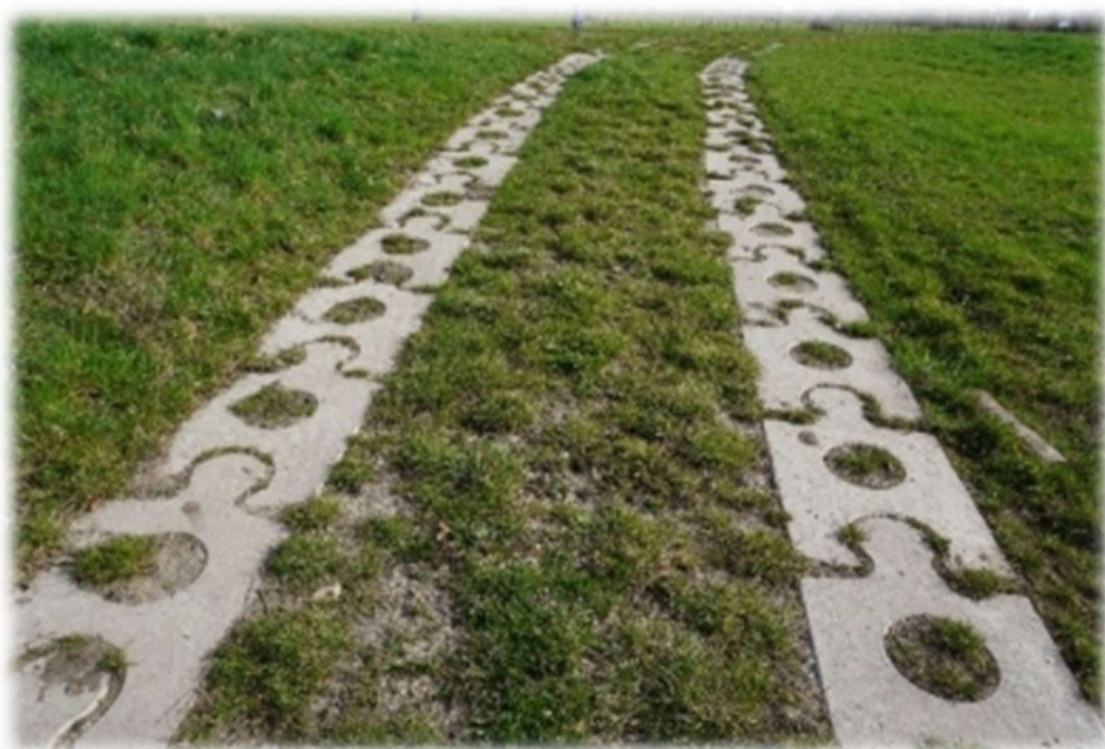
Příklad kolejové polní cesty z betonových prefabrikátů
