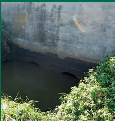
1. Nevhodné řešení. Propustky, u kterých voda přesahuje třetinu jejich průřezu, jsou pro vydru většinou neprůchozí.
