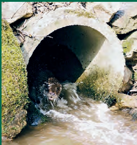
2. Vhodné řešení. Propustky, kde množství protékající vody umožňuje vydře jít po dně, jsou pro ni většinou průchozí.
