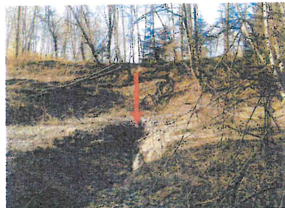
pravděpodobné vyústění potrubí spodní vypusti
