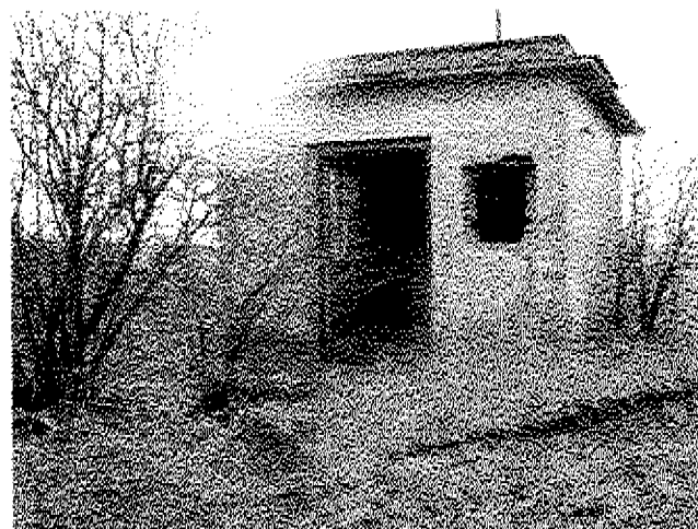
Obr.č. 16 Objekt vodárny
