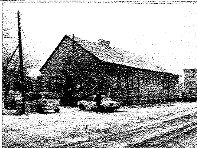
Obr. č. 2 Administrativní budova p.č.1574/8
