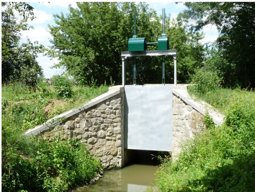
Ukázka – stavidlo Tlumačov
