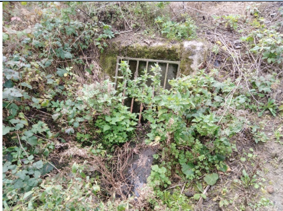
Obdélníkový vtokový profil ( b=0,6\text{ m} , h=0,9\text{ m} ) do zatrubnění DN 400.
