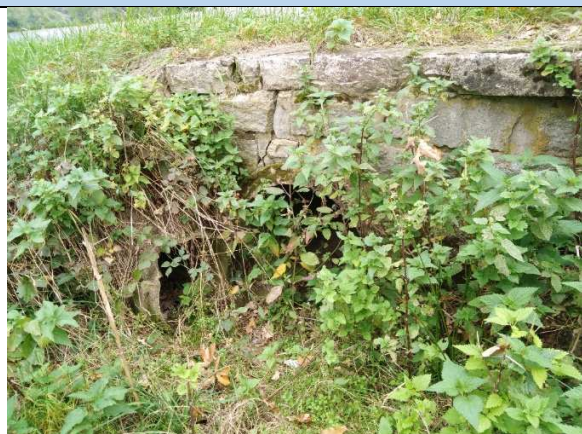
Nekapacitní propustek kritického bodu přes silnici III/02031.
