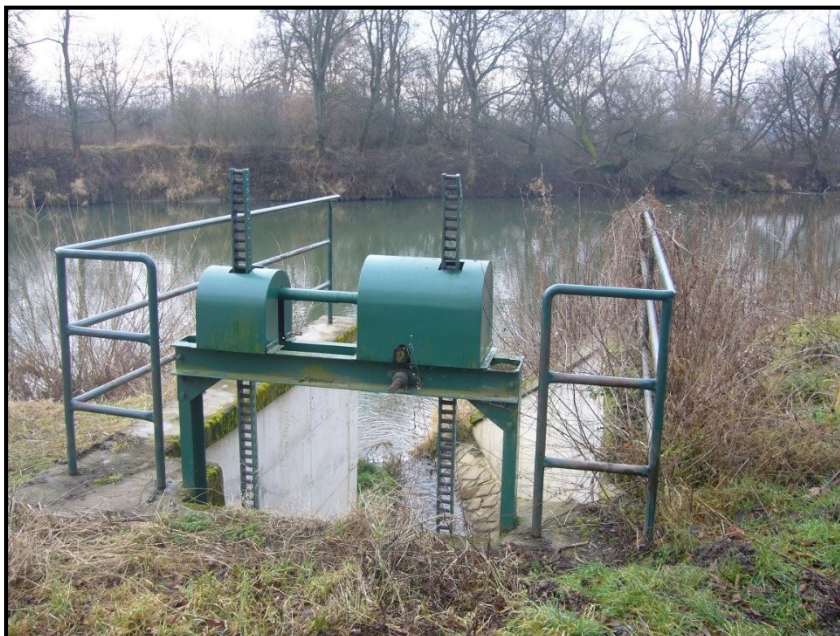
Ukázka – Stavidlo Vacenovice
