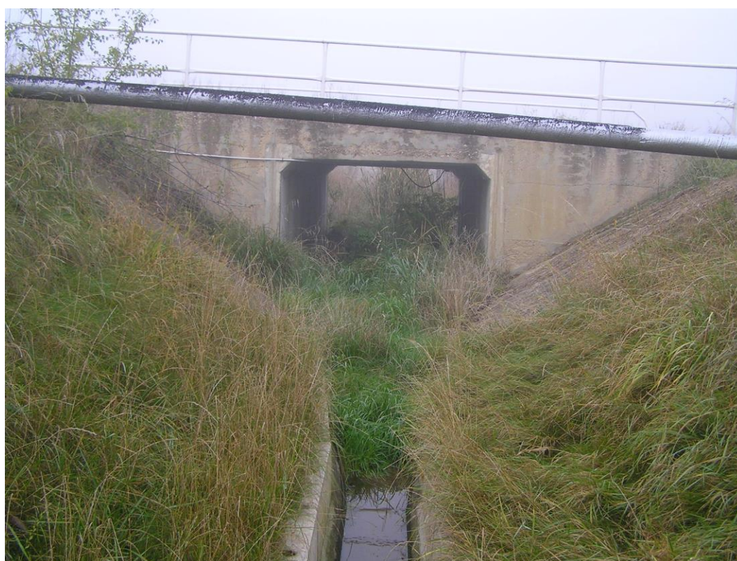
Rámový propust na Vysočanské svodnici
