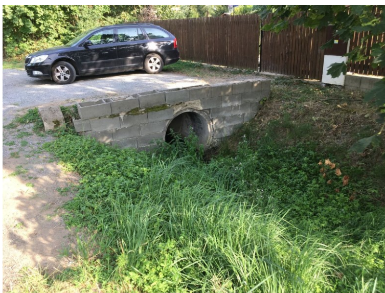
Obrázek 41: Ukázka propustku pod příjezdovou cestou (DN 1000)
