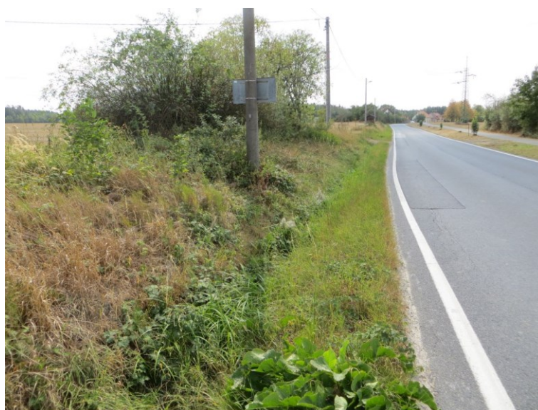
Obrázek 59: Příkop podél komunikace vedoucí do propustku
