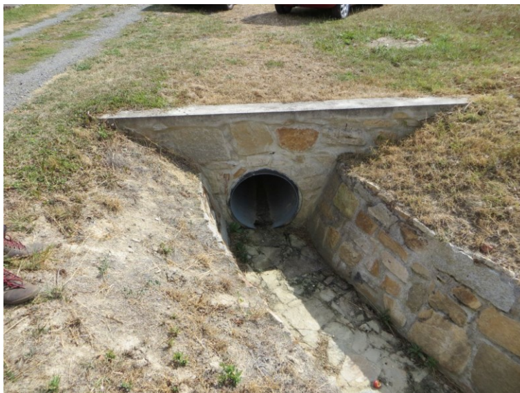
Obrázek 54: Předcházející propustky (DN 800), výtok
