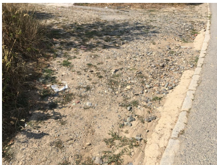
Obrázek 81: Eroze místní komunikace
