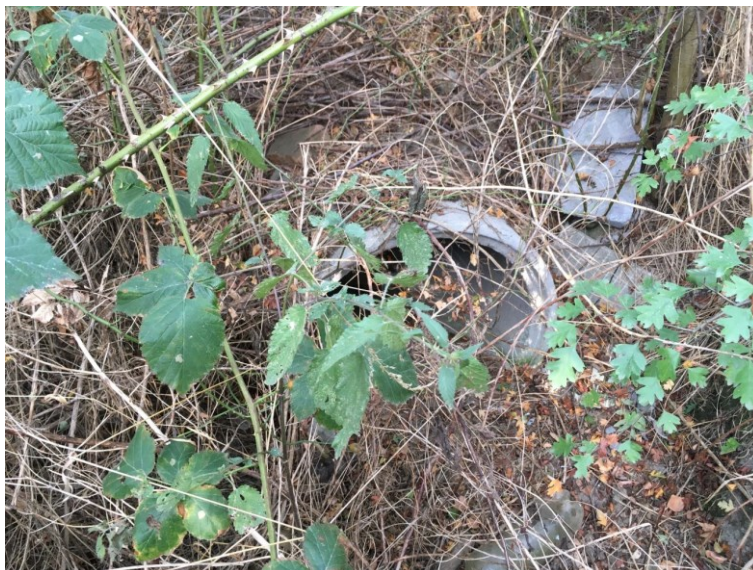
Obrázek 40: Problémový bod (propustek DN 800)
