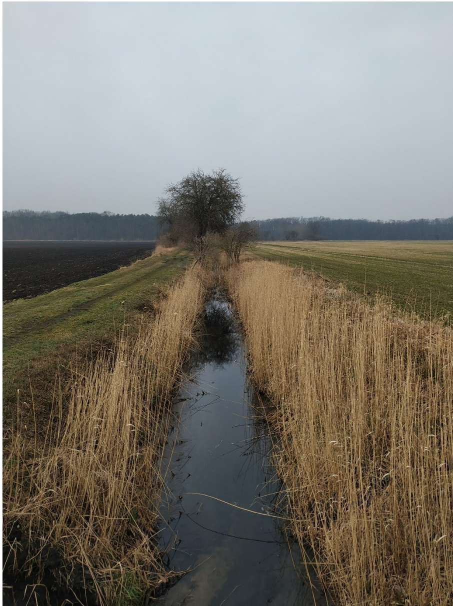
Pohled proti směru linie HOZ z propustku cca v 0,750 km
