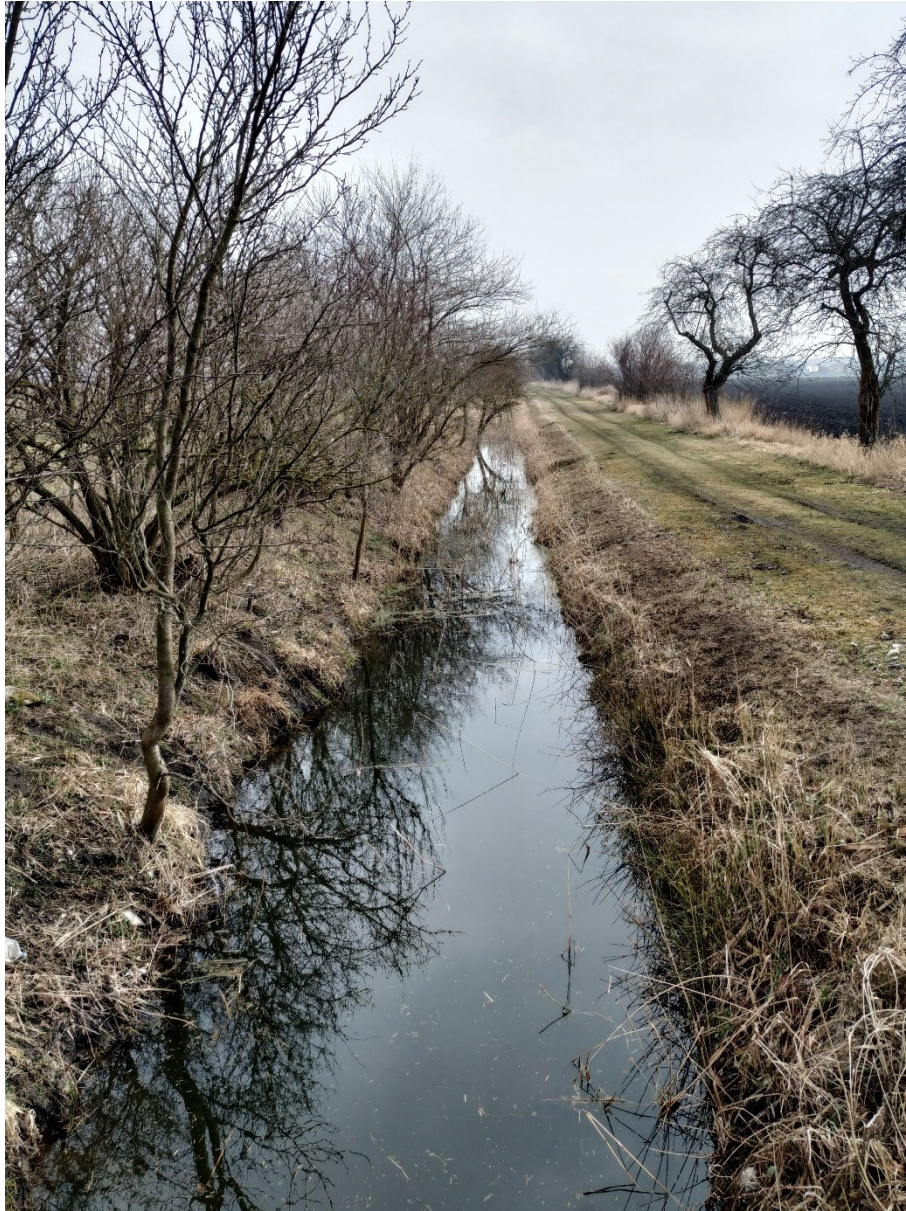
Pohled od propustku po směru linie HOZ v cca v ,360 km
