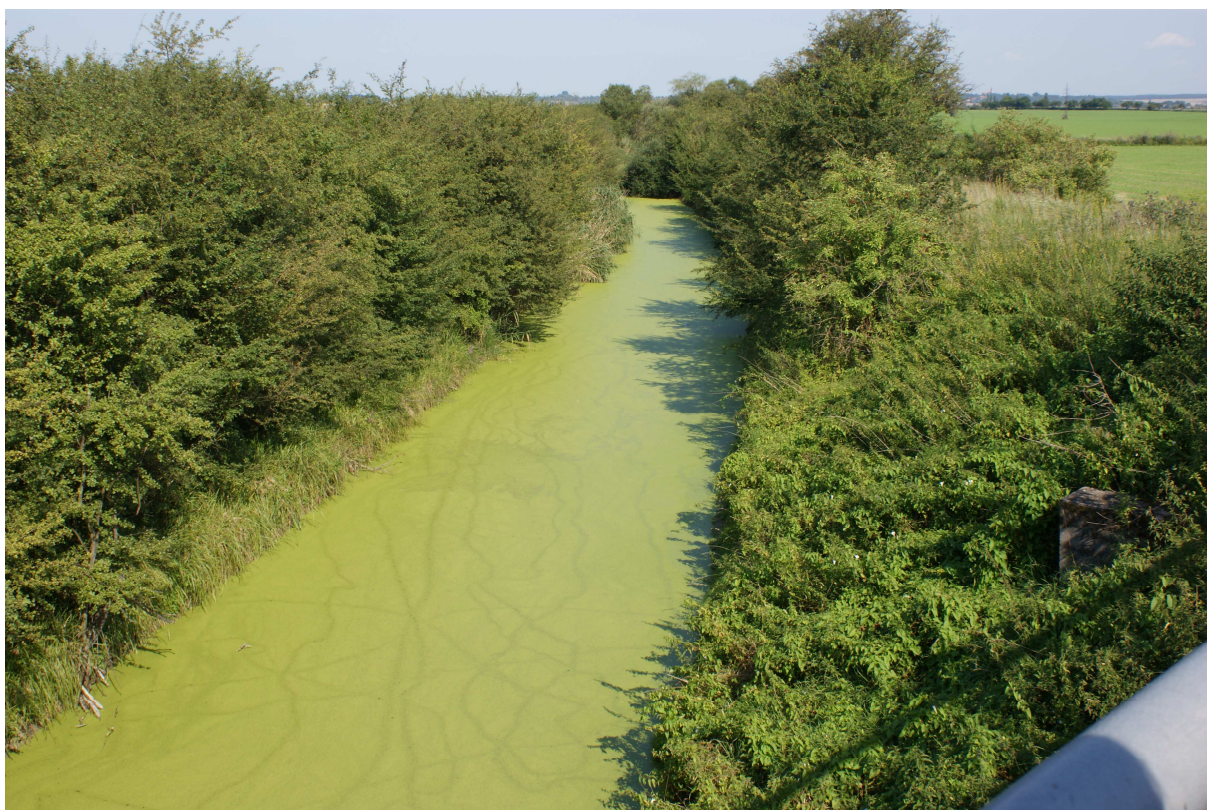
LBK „Blatnice“ – stávající zeleň na ochranných hrázích má být odstraněna – pozemky pro nové založení LBK jsou vyčleněny po pravé straně ve směru toku.
