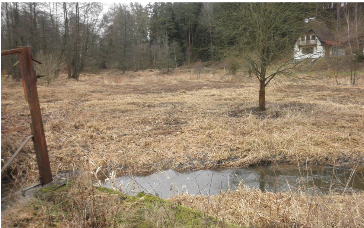
Foto 1: Pohled na lokalitu nádrže ze stávající hráze
