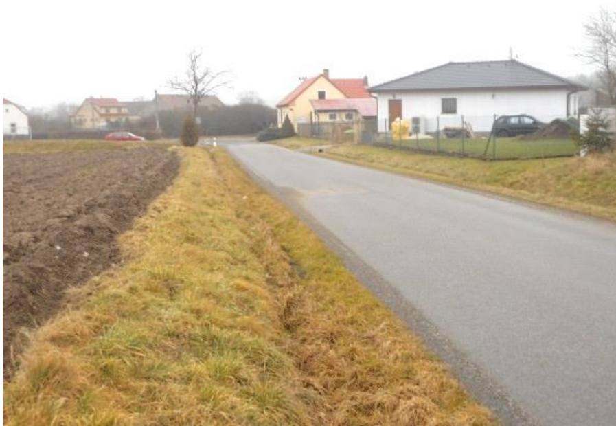
obrázek 2 – Rozhled vlevo ze sjezdu z konce polní cesty NCH3 na silnici III/1424, bez překážek v rozhledu, skutečná délka rozhledu 100m.
