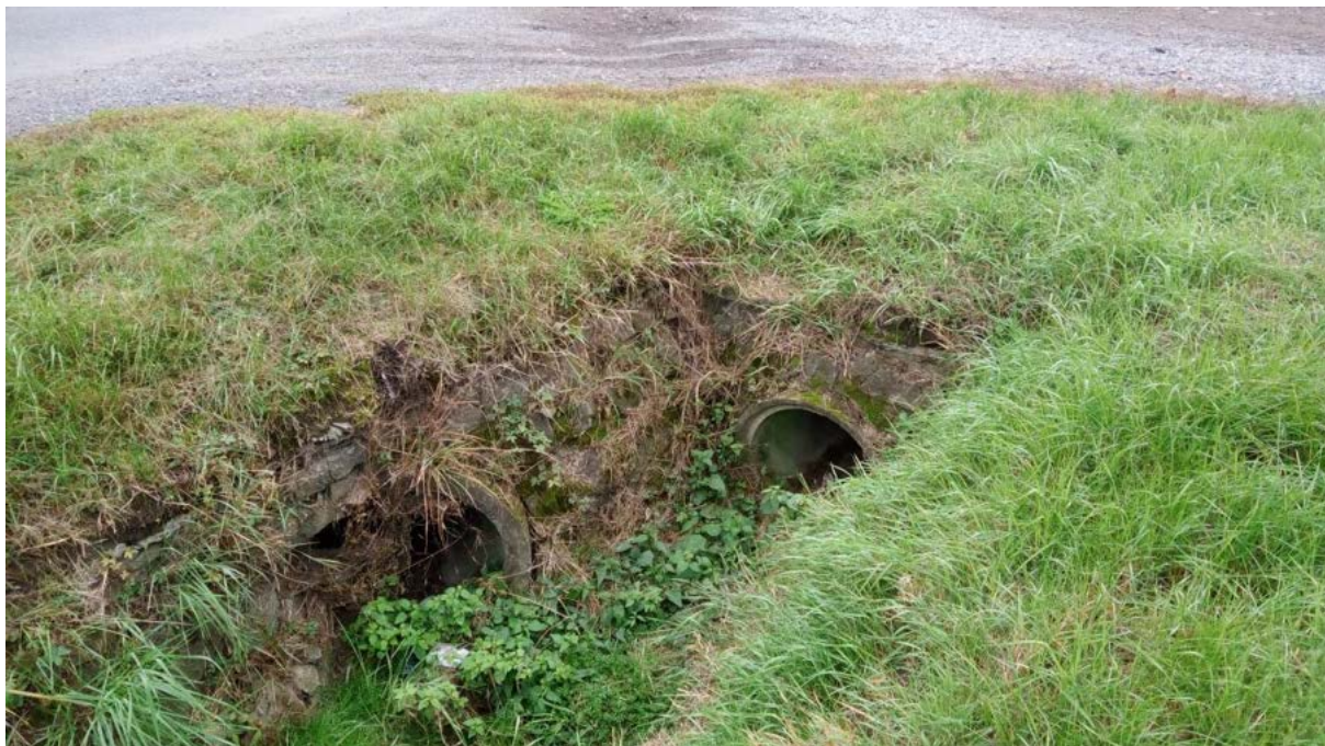
Obr. 26: Propustek pod komunikace
