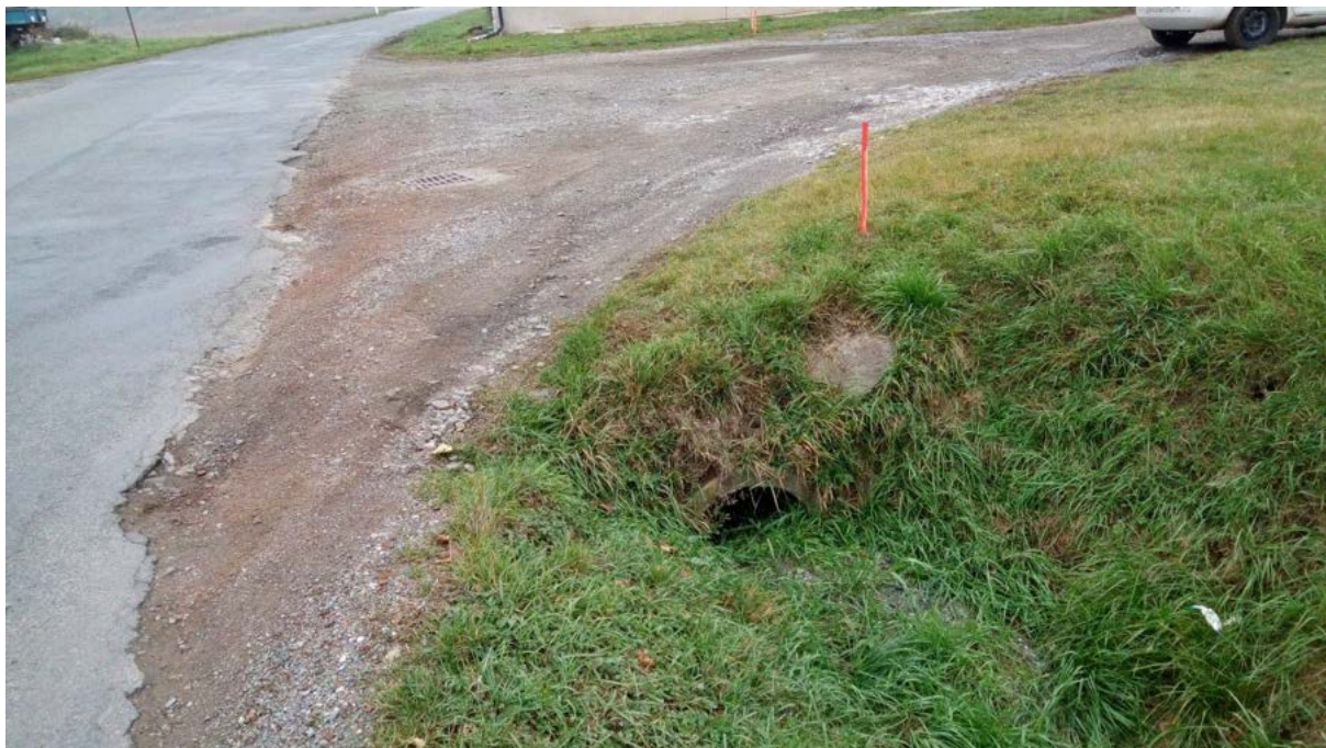
Obr. 27: Vyústění propustku
