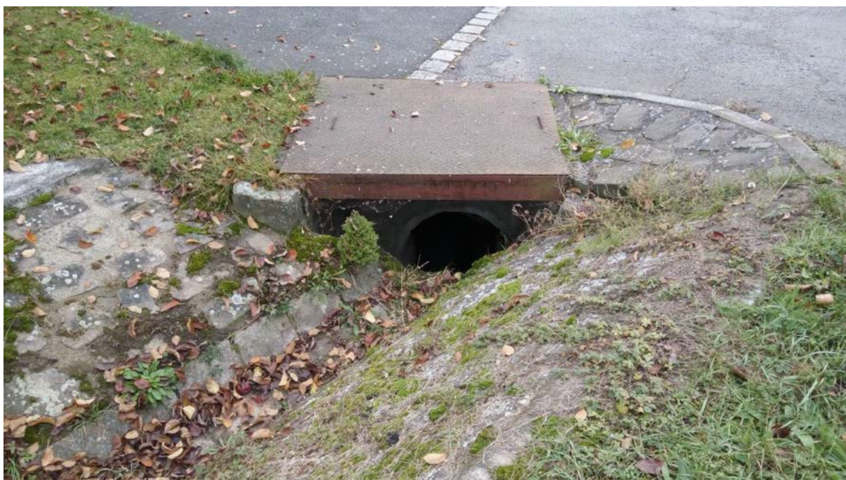
Obr. 30: Propustek v trase cestního příkopu
