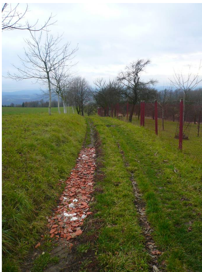
Foto 10: Záhumenková cesta C6 vyspravená stavební sutí.
