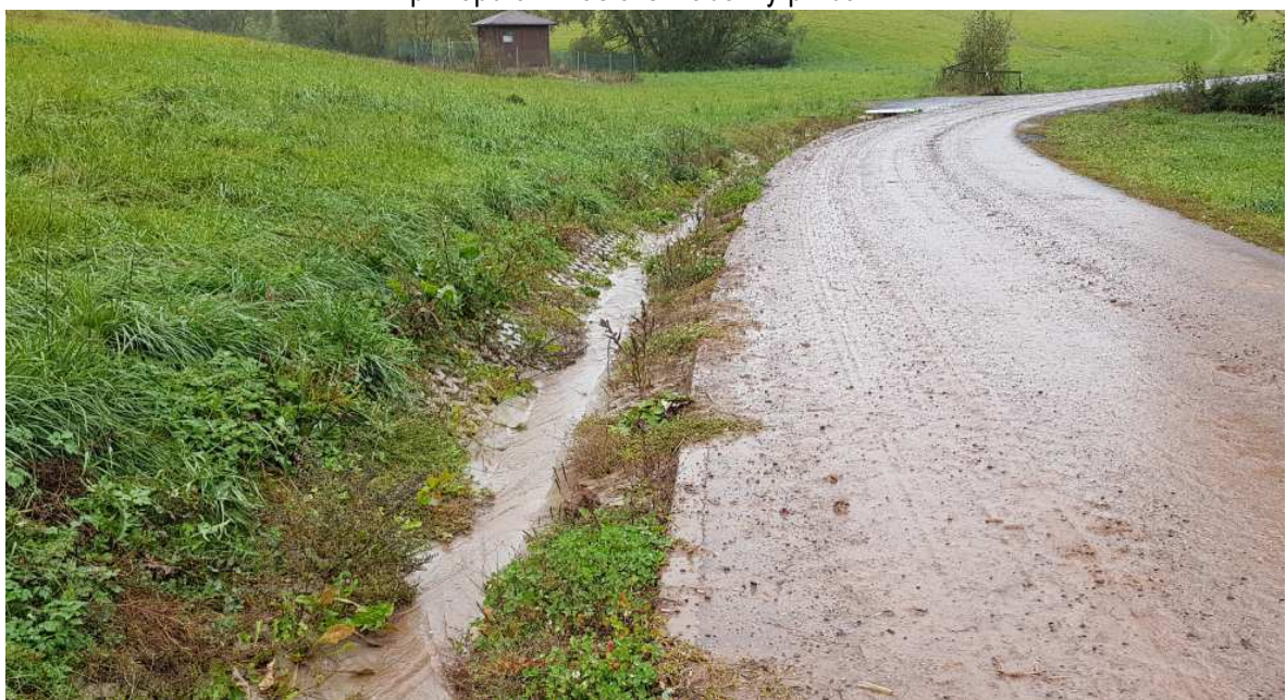
pohled na asfaltový úsek správně odvodněné cesty z katastru Syřenov směrem k napojení C15 na tuto cestu – vlevo od cesty odvodňovací příkop ze zatravňovacích tvárnic chránících stabilitu svahů příkopu a z klasické žlabovky při bázi
