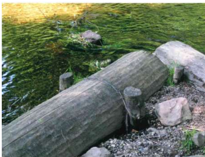
Obr. 2 ukázka zakotvení říčního dřeva
