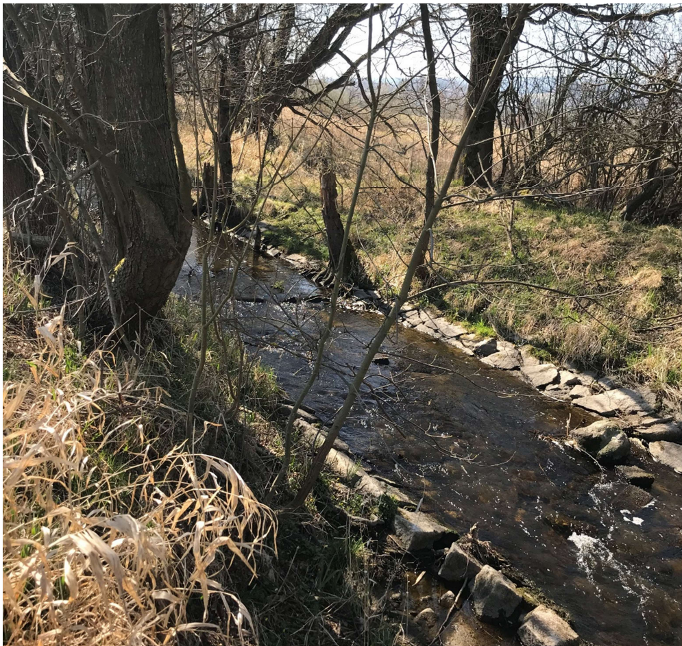
Obr. 1 Stávající prizmatické opevněné koryto
