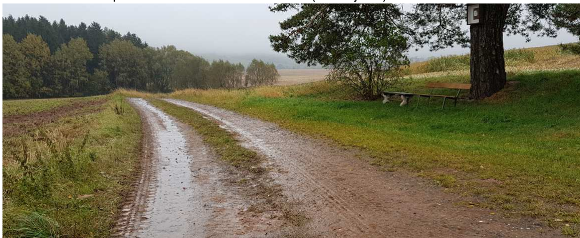
pohled na problematický úsek u sondy 8, kde bude nutná úprava povrchových vrstev a odvodnění
