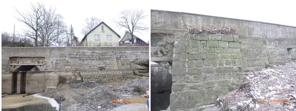
Obrázek 5 – Stav navazujících křídel (vlevo návodní strana, vpravo povodní strana)
