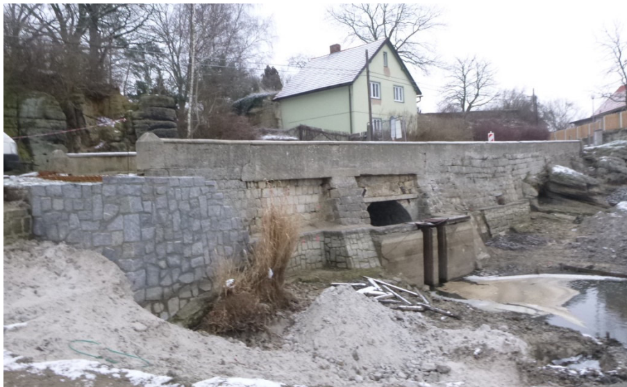
Obrázek 2 – Pohled na most od rybníka (po proudu Bobřího potoka)
