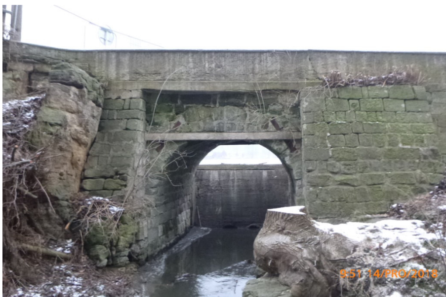
Obrázek 3 – Pohled na most proti proudu Bobřího potoka
