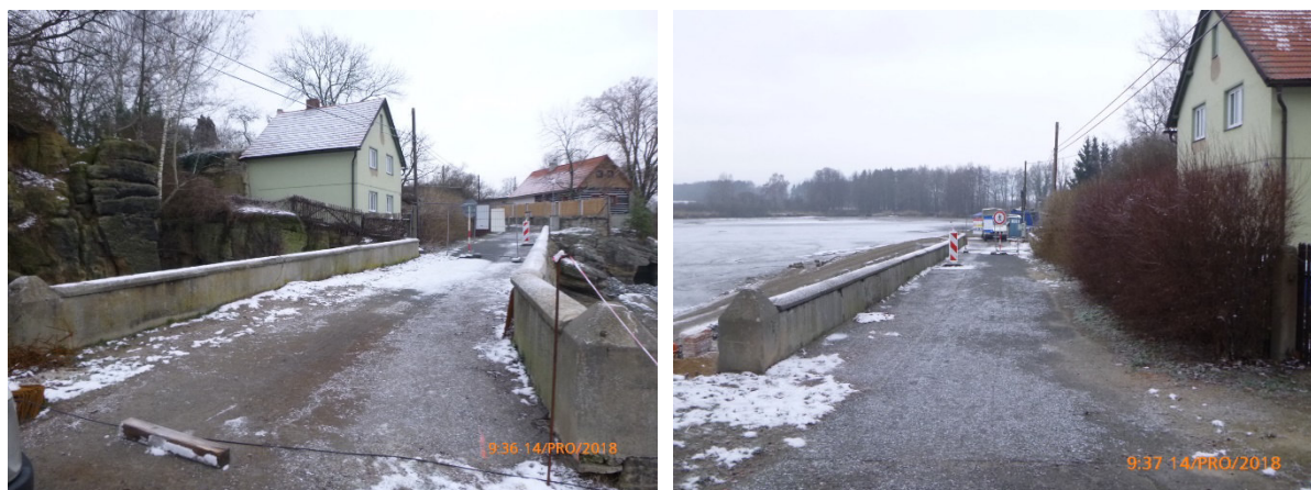
Obrázek 10 – Pohled na most ve směru (vlevo) a proti směru (vpravo) staničení
