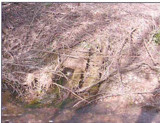
E. betonová drenážní výust, funkční, teče z ní čistá voda
