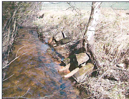
R. betonová prefabrikovaná drenážní výust, funkční, průtok slušného množství železité vody
