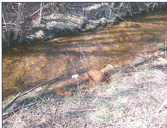
U. betonová prefabrikovaná drenážní výust, funkční, průtok malého množství železité vody
