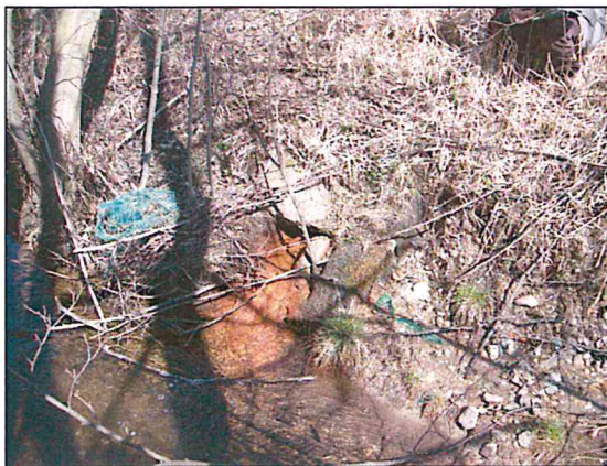
S. betonová prefabrikovaná drenážní výust, funkční, průtok malého množství čisté vody
