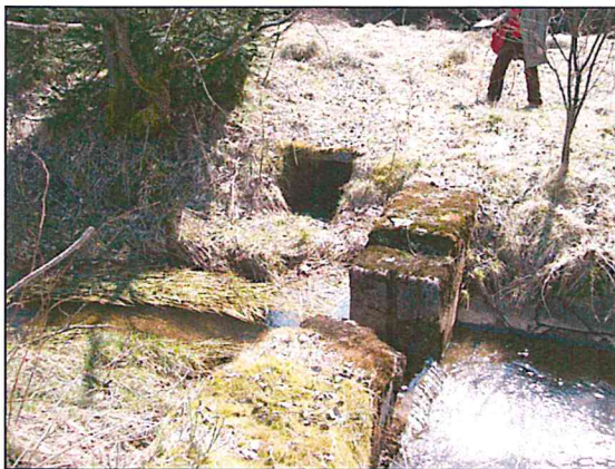
123. betonová drenážní šachta, stojatá voda, okolí šachty je zamokřeno
