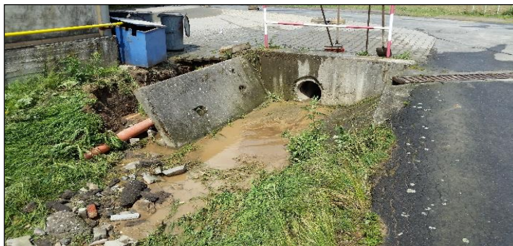
Foto 15: Pohled na zatrubnění (DN400) pod ulicí Opavská a viditelné poškození břehů po povodňové události
