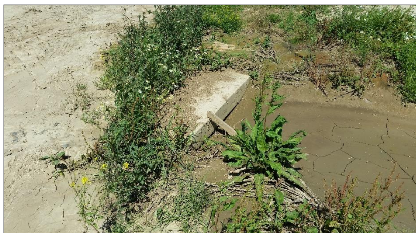
Foto 3: Detail na zanesený propustek nacházející se u asfaltové polní cesty
