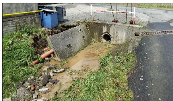
Foto 13: Pohled na zatrubnění (DN400) pod ulicí Opavská a viditelné poškození břehů po povodňové události
