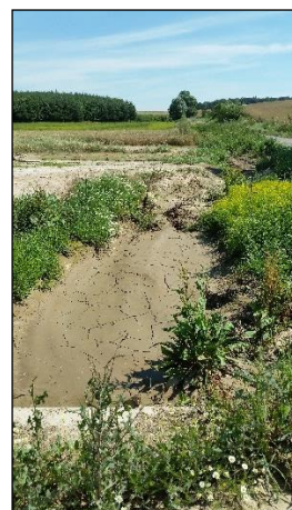
Foto 4: Pohled na zanesený cestní příkop asfaltové polní cesty
