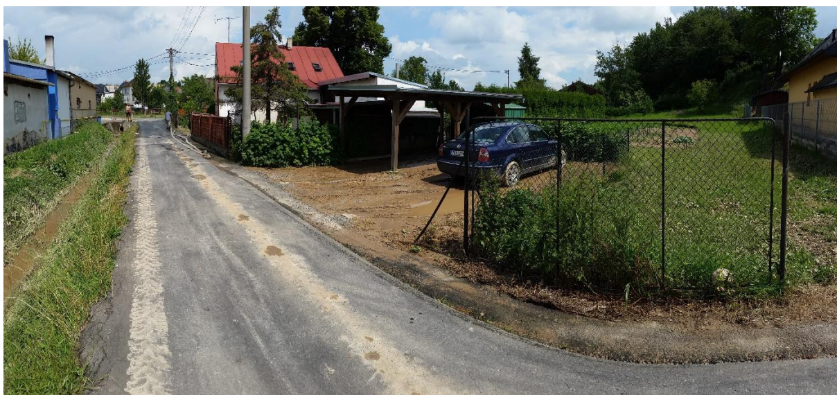
Foto 10: Pohled na přístupovou komunikaci vedoucí podél fotbalového hřiště, viditelné projevy zatopení bahnem pláně komunikace a okolních pozemků
