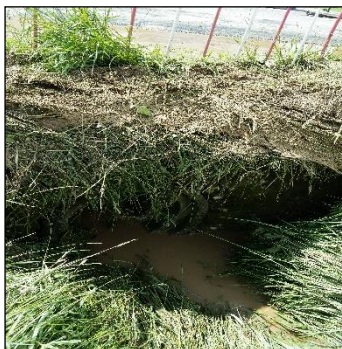
Foto 14: Přímý pohled na téměř ucpáný propustek – přítok od zatravněné údolnice
