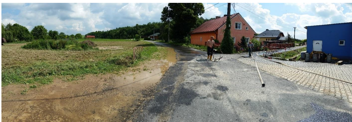
Foto 8: Pohled na závěrový profil u propustku na ulici Opavská před fotbalovým hřištěm, stav po povodňové události, čištění nánosů bahna z povrchu komunikace a blízkého okolí
