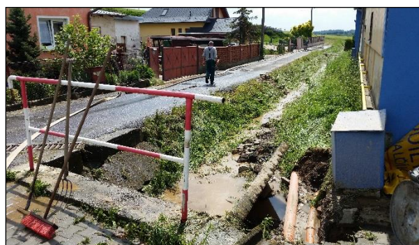
Foto 12: Pohled na odvodňovací příkop vedoucí podél fotbalového hřiště, viditelné poškození břehů po povodňové události
