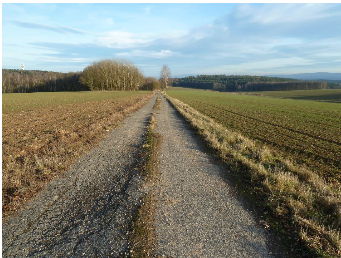
Obrázek 8: Účelová komunikace – Horní Hraničná – absence příkopů
