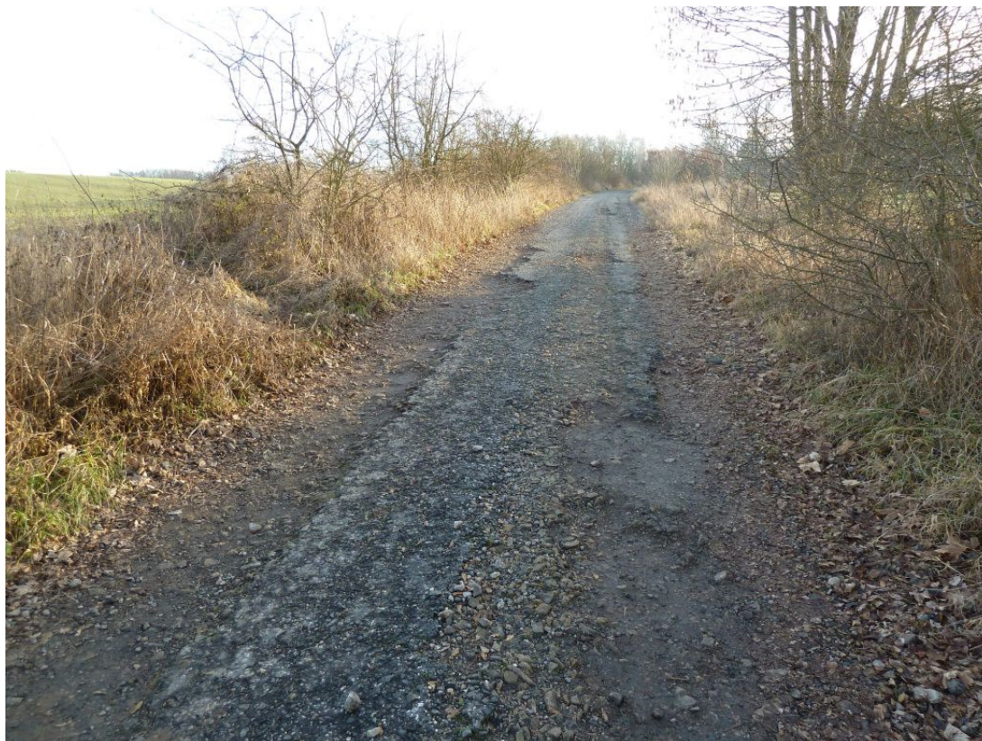
Obrázek 5: Silnice III. třídy č. 2142 – špatný stav vozovky a zarostlé příkopy
