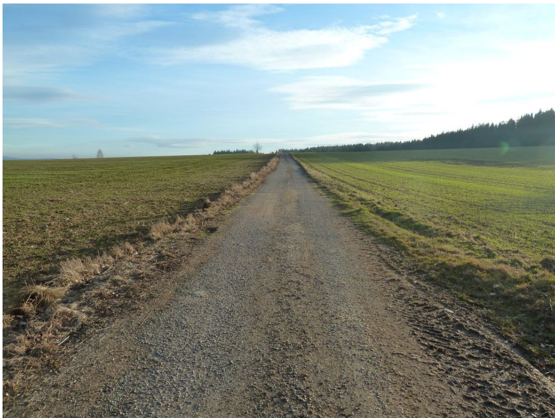
Obrázek 7: Účelová komunikace – Horní Hraničná – absence příkopů
