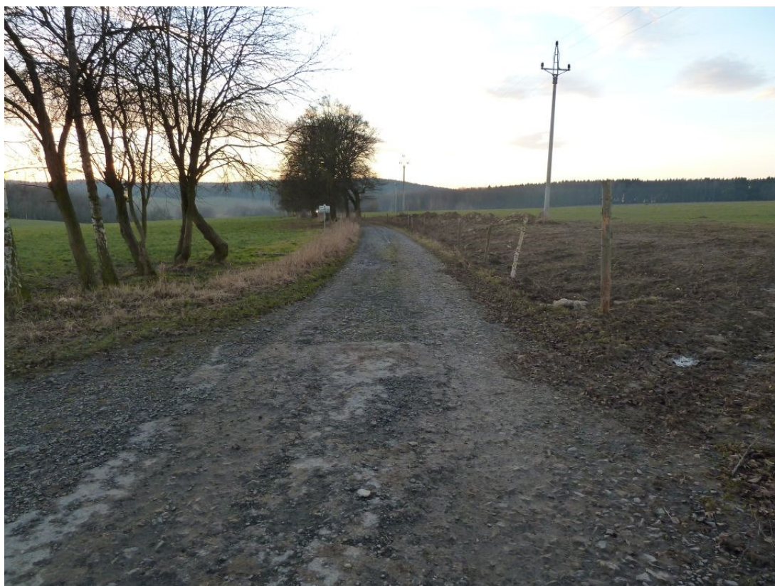
Obrázek 6: Silnice III. třídy č. 2142 – špatný stav vozovky a absence příkopů
