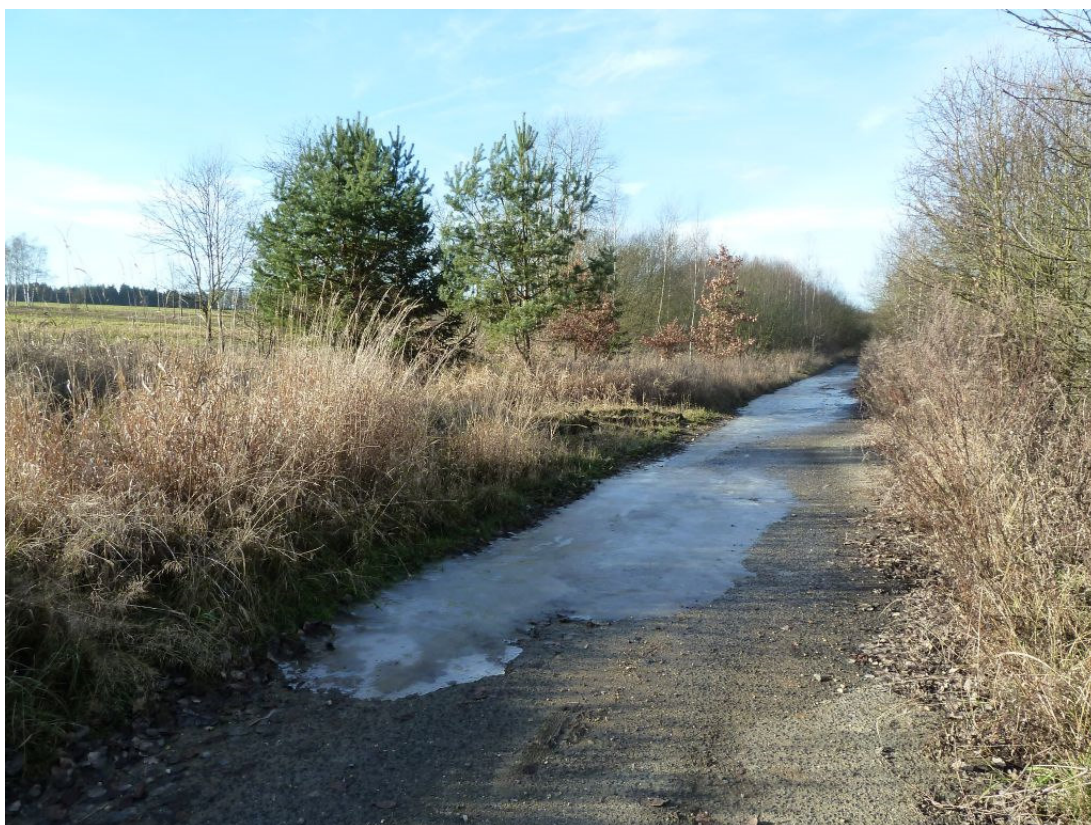
Obrázek 11: Účelová komunikace podél železniční trati - absence příkopu a vytékající voda z pole na cestu
